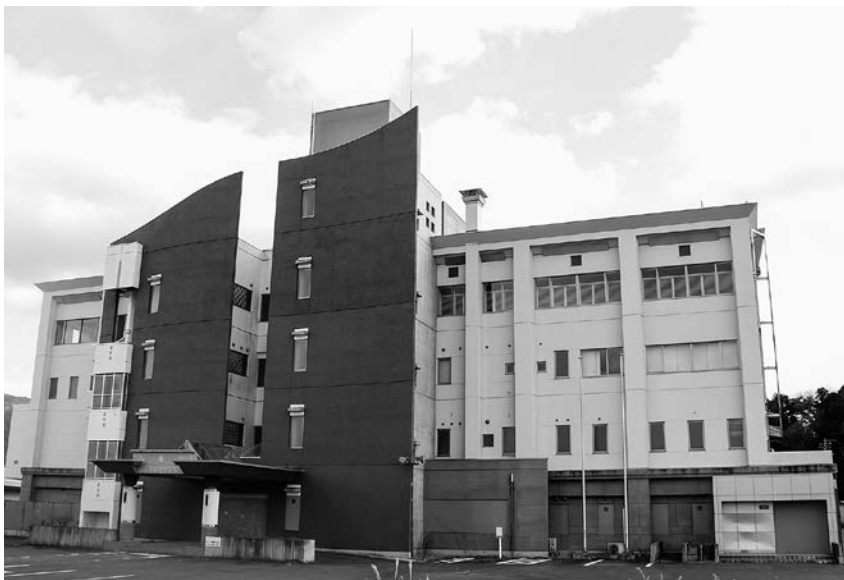
整備予定の宮古市地域創生センター
