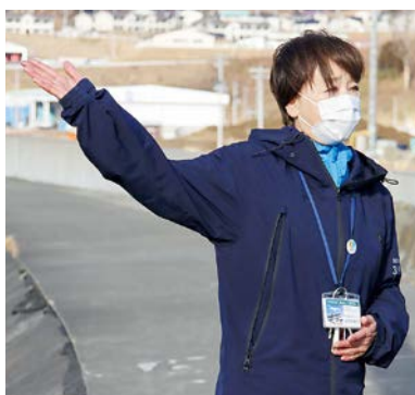
防潮堤の上で震災の被害状況を説明する元田さん
