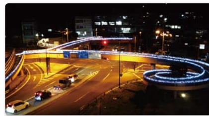
市役所前歩道橋
