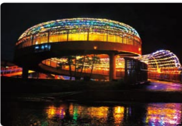
市役所前歩道橋
