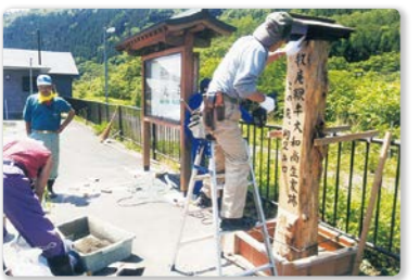
案内標識の設置作業
