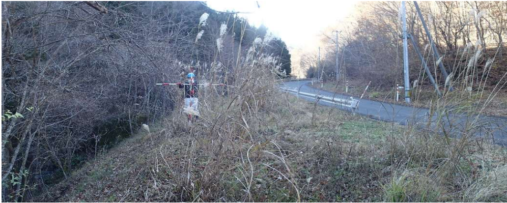
発電所候補地と道路の接続がよい。
