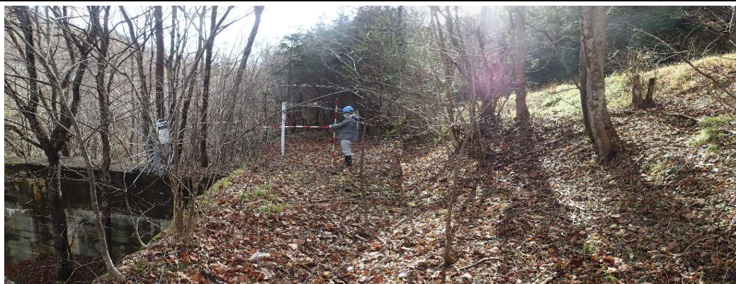
砂防えん堤右岸側と林道の接続がよい。
