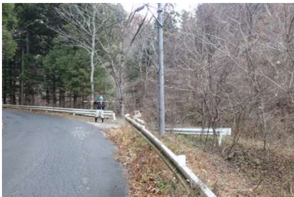
取水候補地右岸側と林道の接続がよい。
