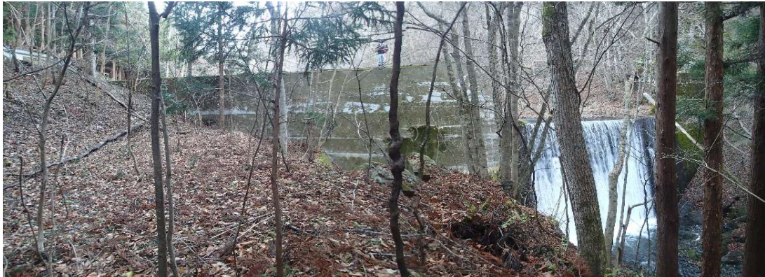
取水候補地正面(尻石沢堰堤、宮古土木センター)。
