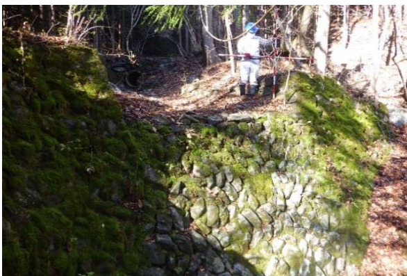
支川をサイホンで通過している。
