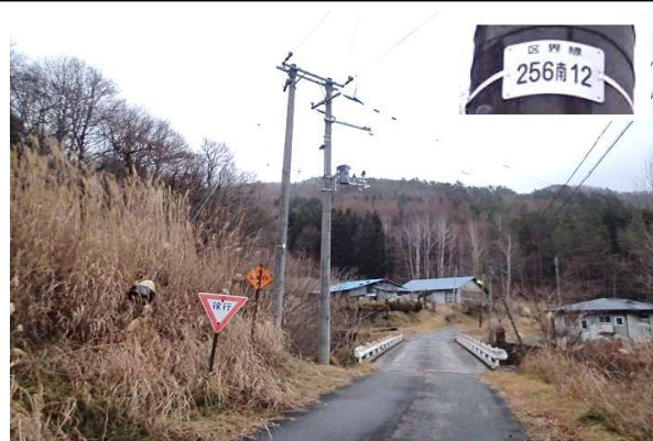
発電所候補地最寄りの高圧配電柱(区界線256南12)。
