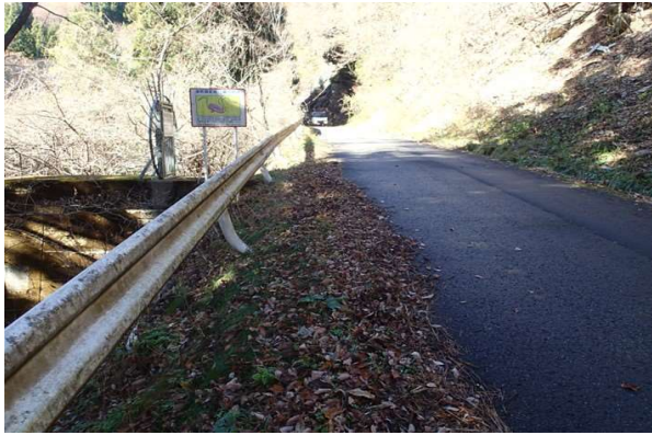
砂防堰堤左岸側と林道の接続がよい。
