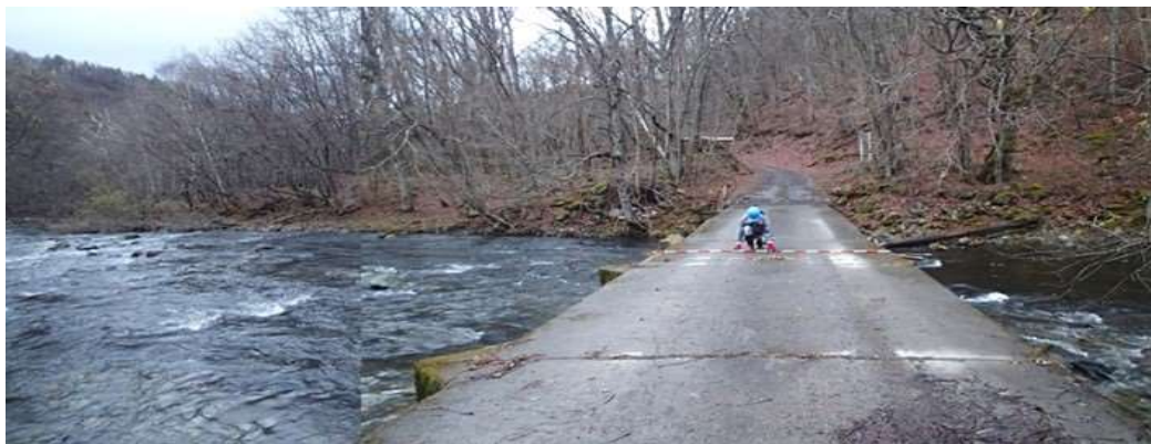
取水候補地より170m下流側、林道通過部の河道現況。
