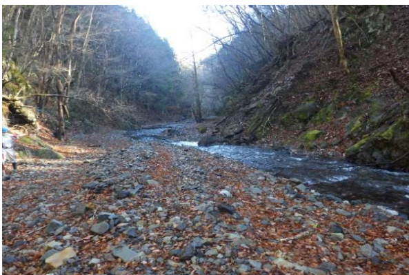
放水地点河道状況
