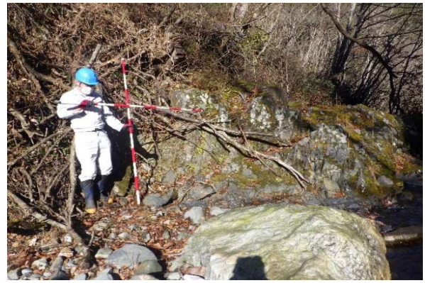
導水トンネル跡。コンクリートで塞いでいる。
