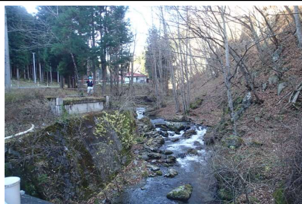
無名橋付近の放水ルート(画面奥建物は静峰苑)。
