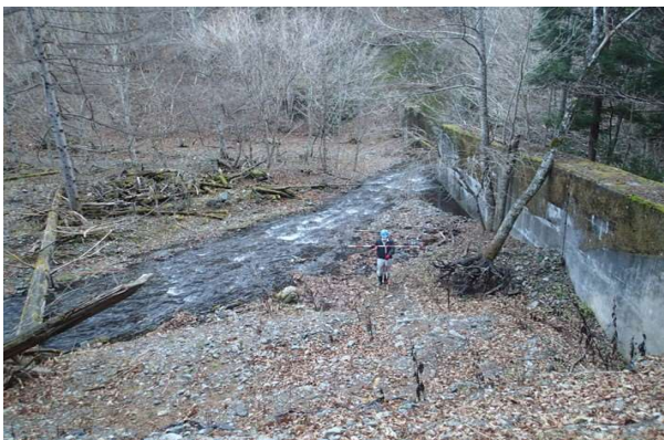
堰堤堆砂状況(満砂)。
