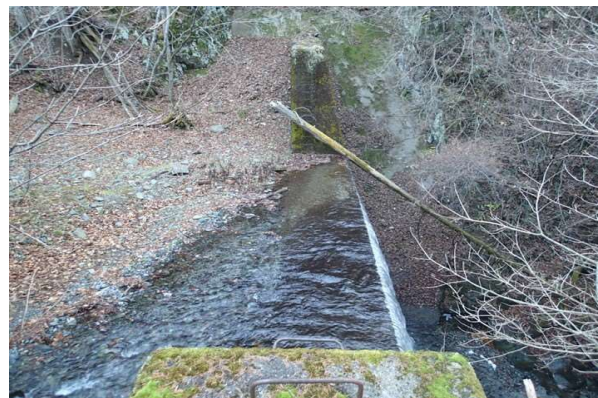
堰堤水通し(天端幅2.4m)。
