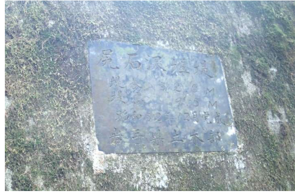
堰堤銘板(尻石沢堰堤、堤長52m、堤高9.5m、S52.12)。
