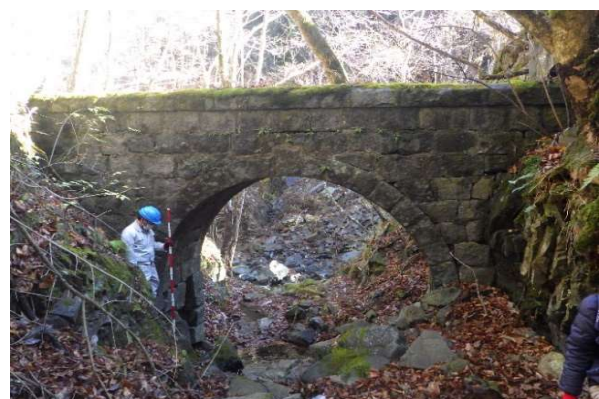
水路橋跡を上流から望む。
