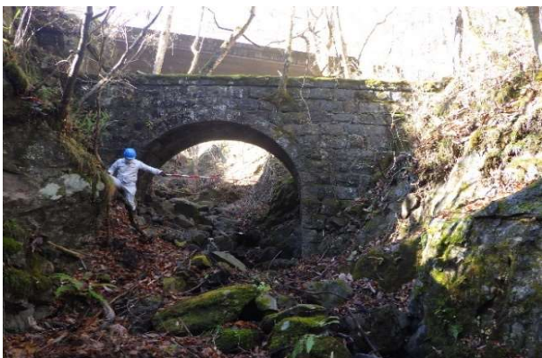
水路橋跡(自然石積)を下流から望む。
