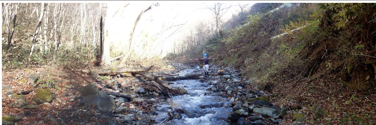
取水候補地正面(河床と道路の高低差が7m程度、堰堤新設)。
