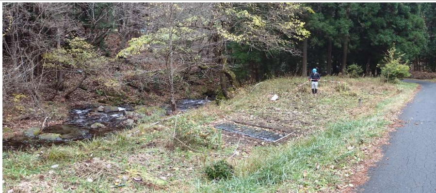
発電所候補地および資材置き場等に利活用できる土地。
