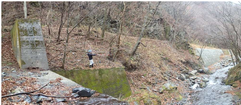
取水候補地下流左岸側の沈砂池に利活用可能な土地。
