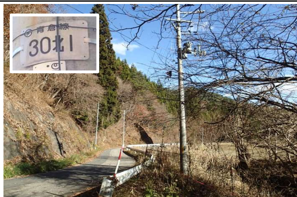
発電所候補地最寄りの高圧配電柱(青倉線30北1)。
