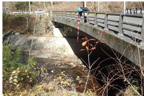
水路ルート橋梁通過部(馬草橋)。
