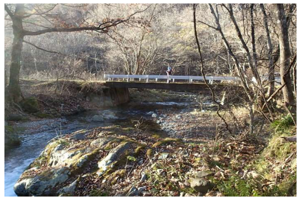
発電所候補地下流側、熊穴沢との合流部。
