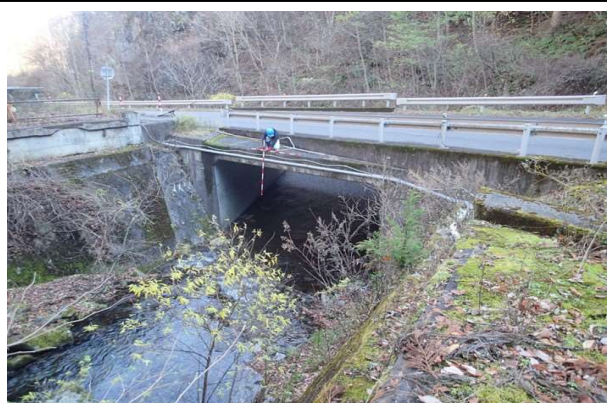
放水ルート下流側の橋梁通過部(無名橋)。
