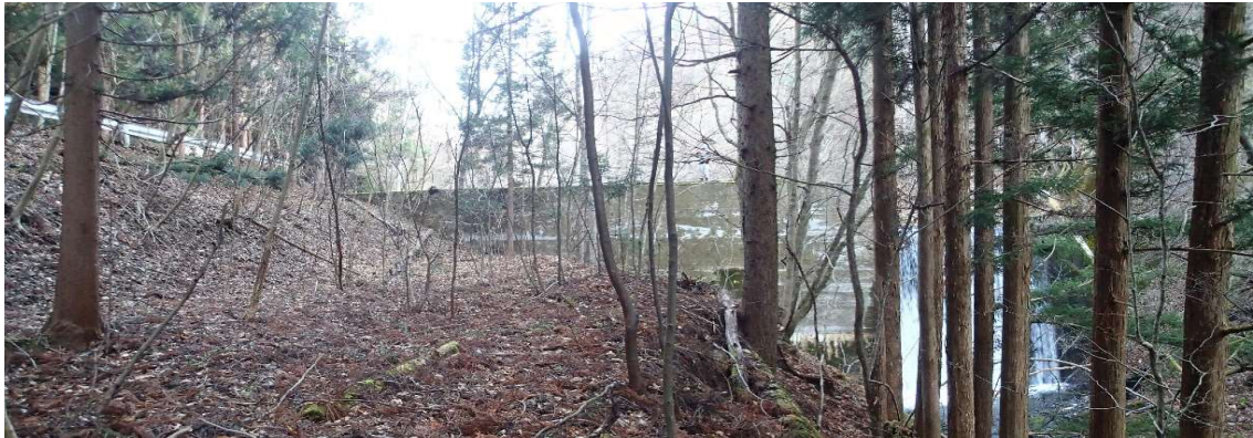
砂防堰堤右岸側と林道の接続がよい。
