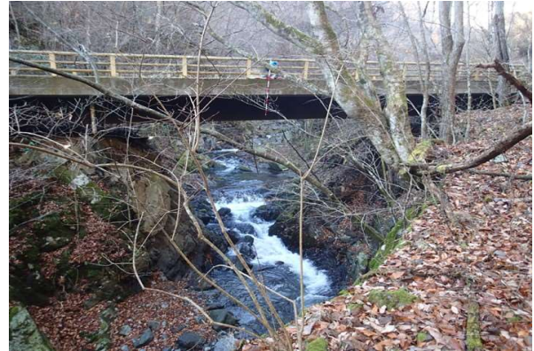
放水ルート橋梁通過部(害鷹森橋)。
