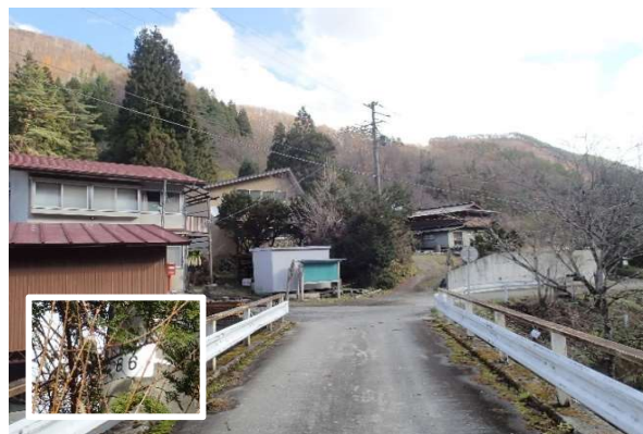
発電所候補地最寄りの高圧配電柱(夏屋線86)。
