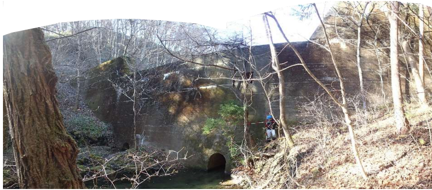
取水候補地正面(養呂地川ハツ石堰堤、昭和44年3月)。
