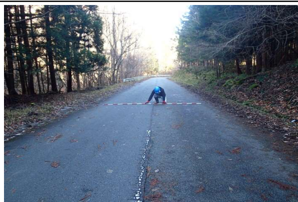
道路は順勾配のため放水ルート設置に適している。
