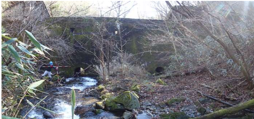
砂防堰堤堆砂状況(未満砂)。
