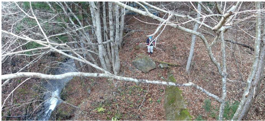
砂防堰堤下流右岸側の沈砂池に利活用可能な土地。
