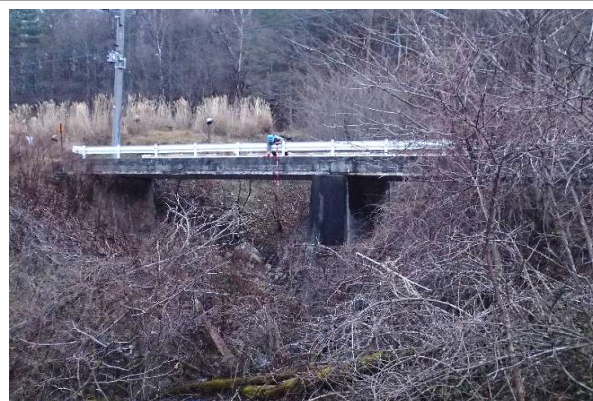
放水ルート橋梁通過部(早池峰3号橋)。
