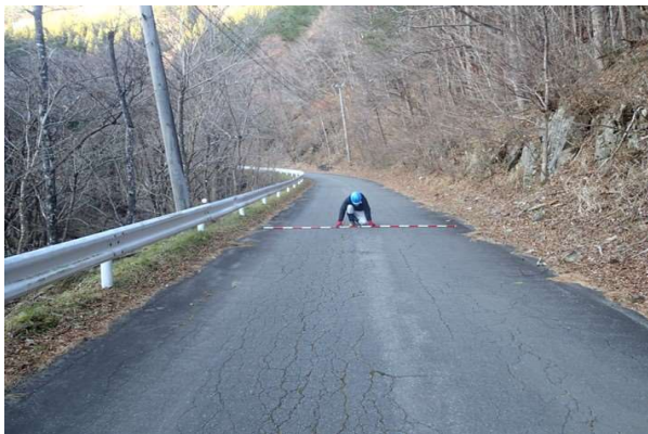
路は順勾配のため放水ルートに適している。
