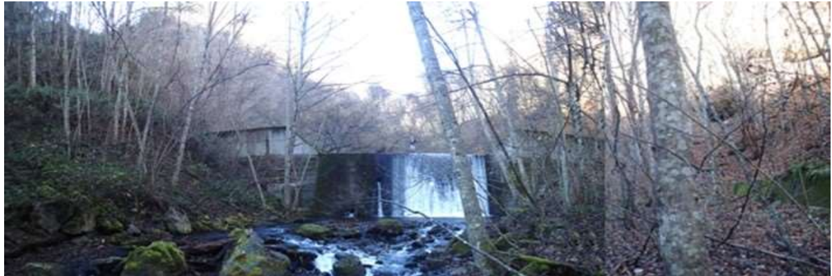
取水候補地正面(堰堤既設、名称不明、所管不明)。
