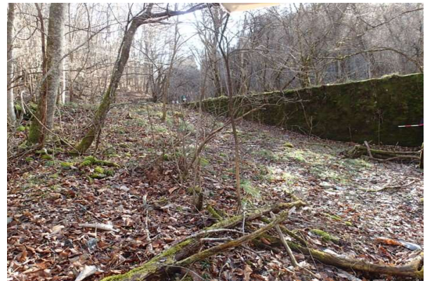
治山施設右岸側と林道の接続がよい。
