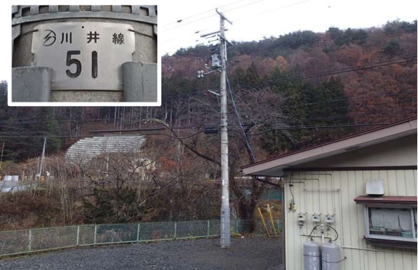
発電所候補地最寄りの高圧配電柱(川井線51)。
