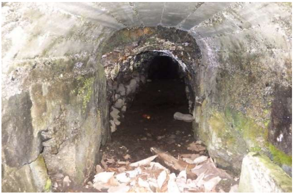
導水トンネル内部
