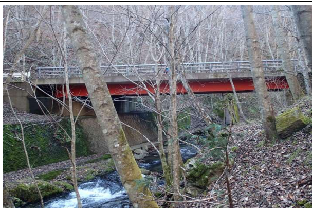
放水ルート上流側の橋梁通過部(栗木平橋)。
