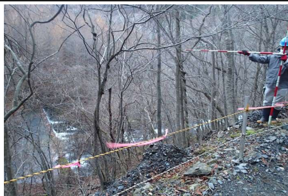
沈砂池に活用できる土地遠景(堰堤下流右岸側)。
