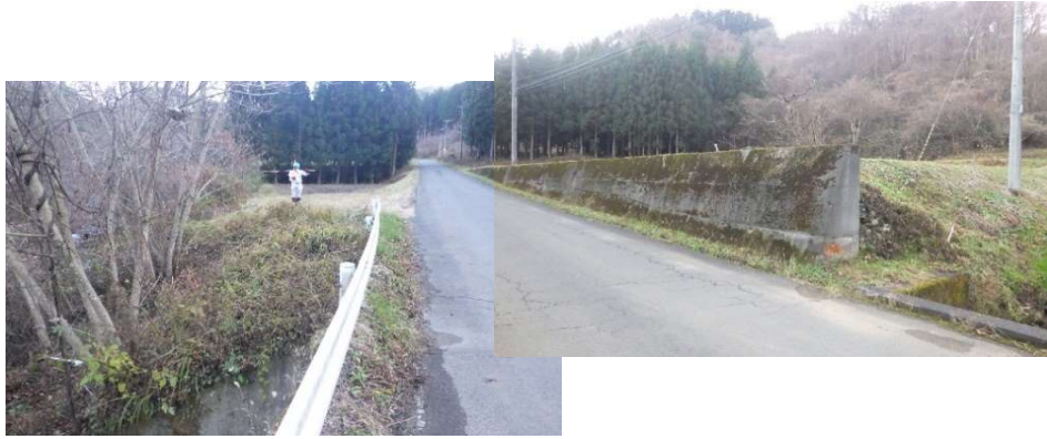
発電所があったと推定される段丘面と水圧管路跡の遠景
