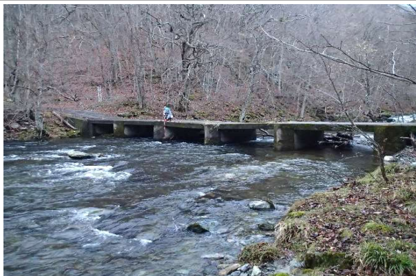
取水候補地より170m下流側林道通過部(無名橋)。
