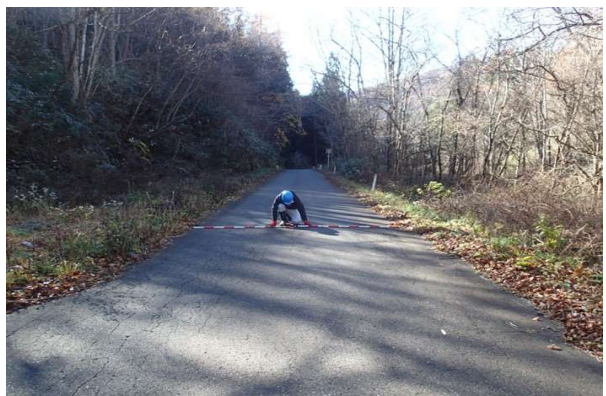
林道は順勾配のため放水ルート設置に適している。
