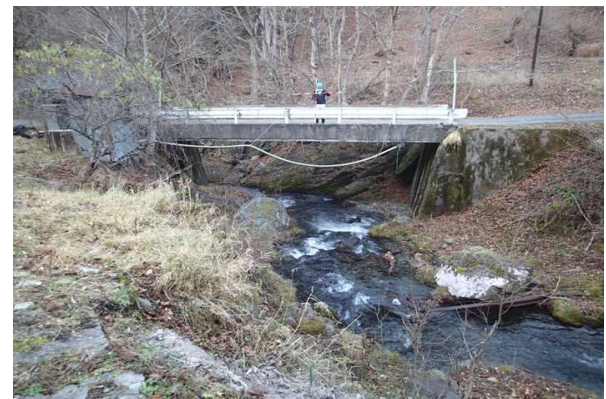
放水ルート橋梁通過部(無名橋)。
