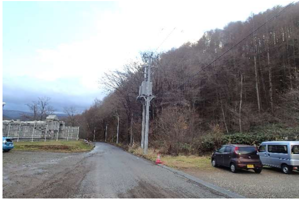
放水ルート中間付近、株式会社ウツィかわい付近の林道現況。
