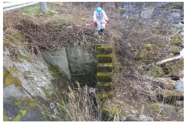
沈砂池跡、導水路入口
