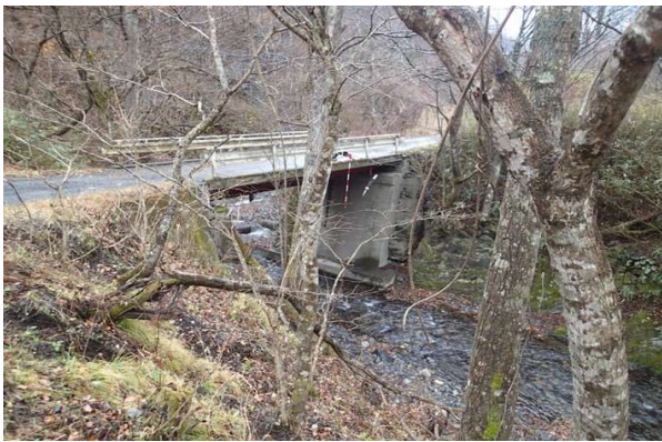
放水ルート桥梁通過部(無名橋)。
