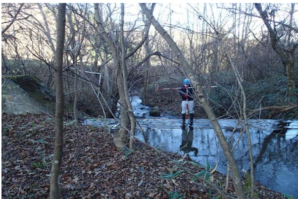
治山施設水通し(天端幅1.5m)。
