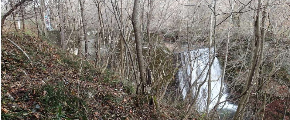
取水候補地正面(夏屋えん堤、宮古土木センター)。
