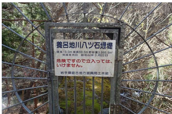
砂防堰堤銘板(養呂地川ハツ石堰堤、宮古土木センター)。
