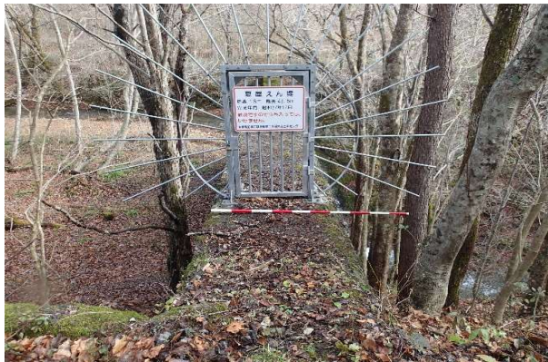
砂防えん堤銘板(夏屋えん堤、宮古土木センター)。
