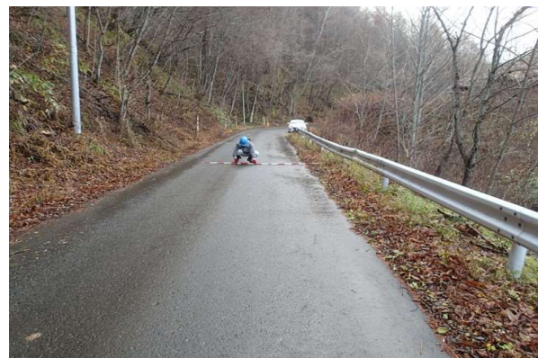
道路は順勾配のため放水ルートに適している。
