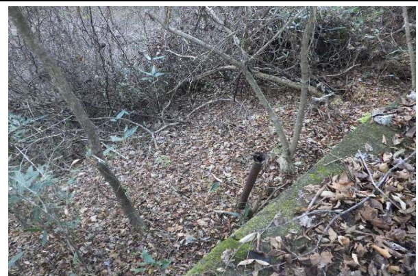
水圧管路跡、給気管が見える。
