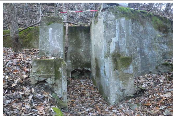
余水路・排砂路跡
