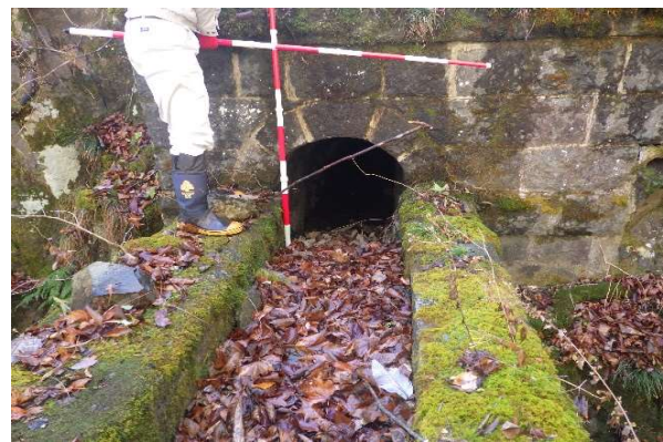
導水トンネル
