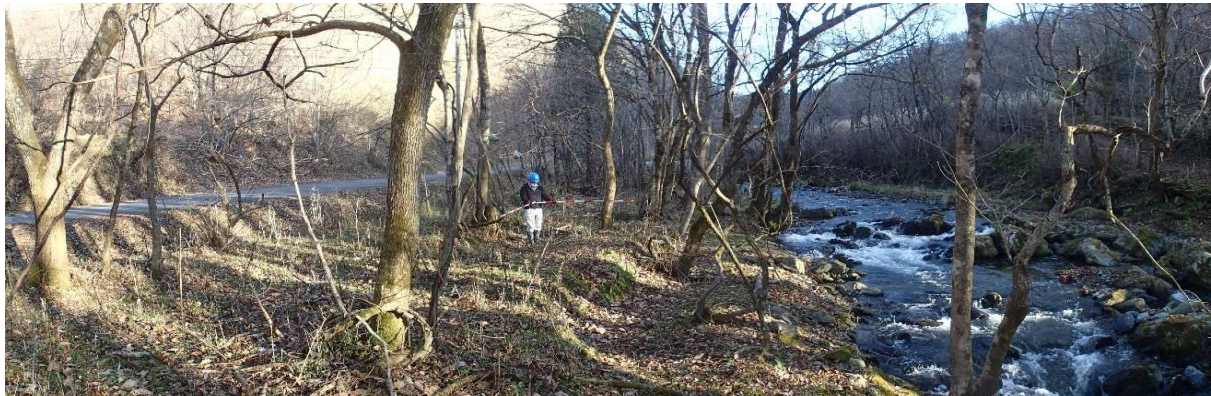
放水候補地右岸側に発電所および資材置き場等に利活用できる土地がある。
