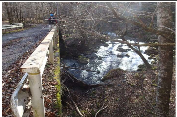
放水ルート橋梁通過部(吉部沢橋)。
