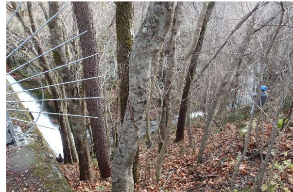
砂防えん堤下流右岸側の沈砂池に利活用可能な土地。
