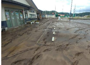
台風19号による道の駅たろうの被災の様子。
