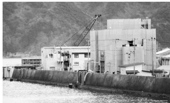
建設中の藤原地区雨水ポンプ場
