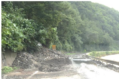
平成28年8月 台風10号 土砂崩れ (国道106号線片栗)
