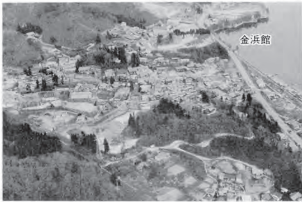
Photo.6 金浜地区 (南西より)
