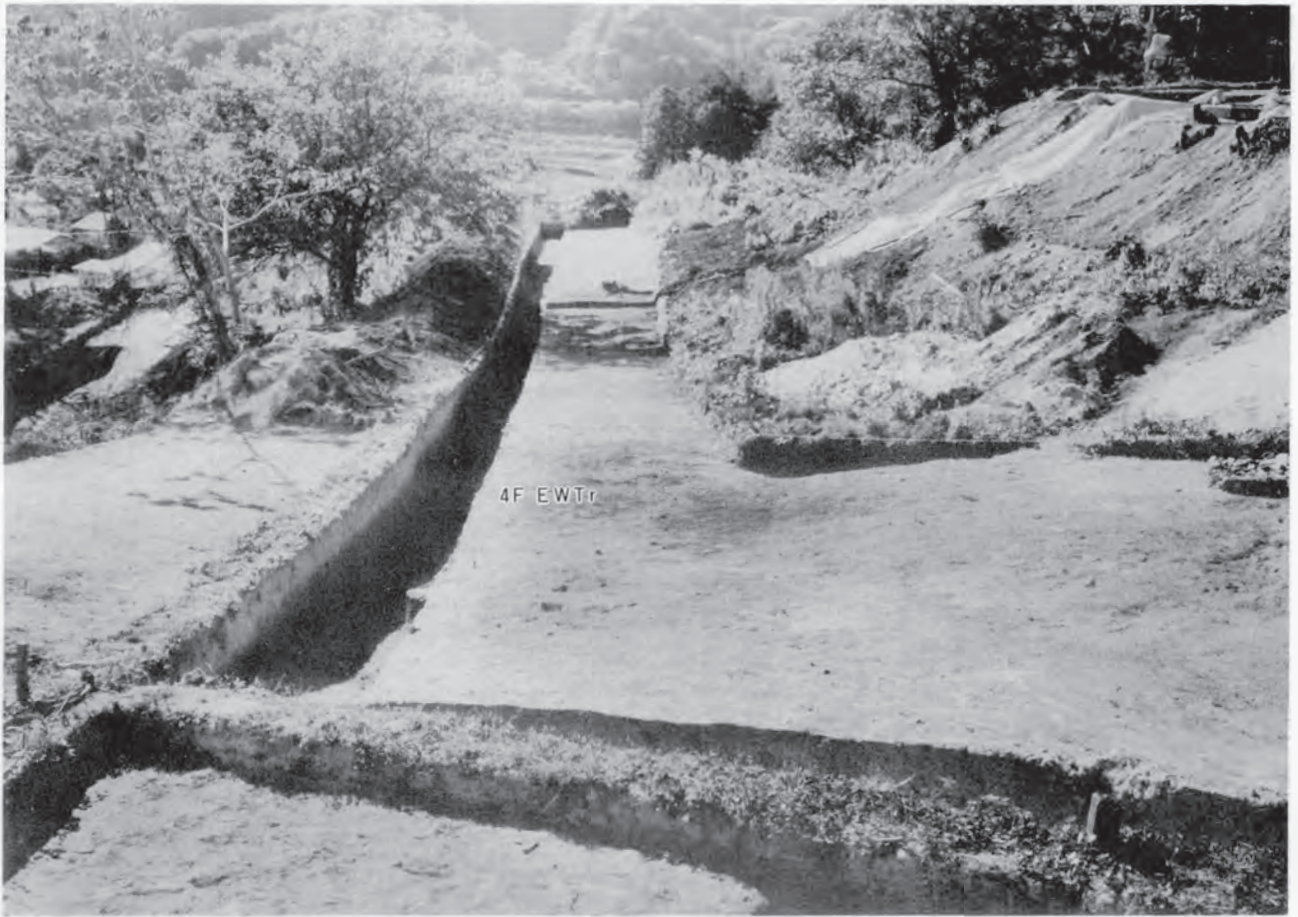
4F区 (東より)
