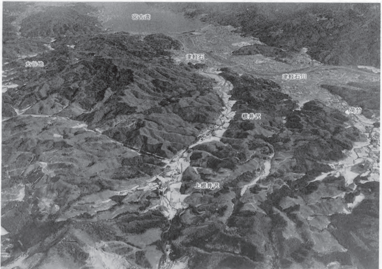
根井沢地区 (南西より)
