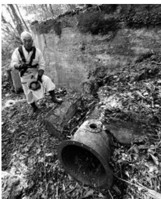
水力発電所で使われていた鉄管が、今でも残っています
