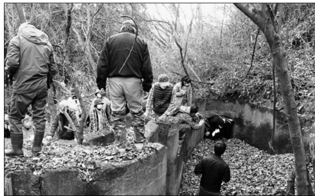
落水口や取水口を見学。当時の痕跡が色濃く残っていました
