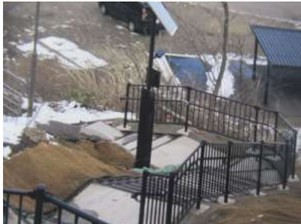
【整備後】避難路
