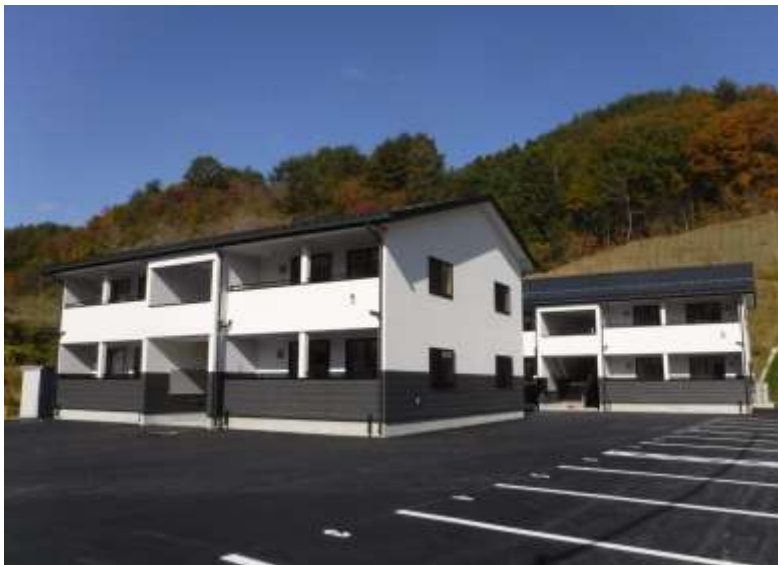
金浜災害住宅(完成)
