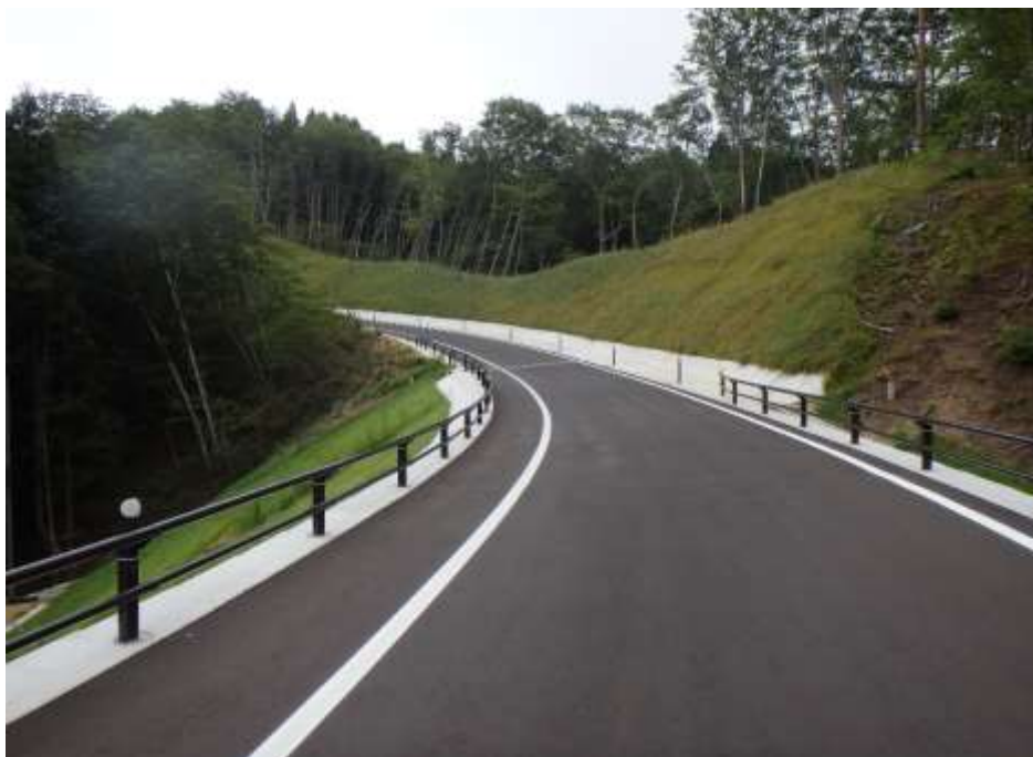
【道路整備(完成)】
