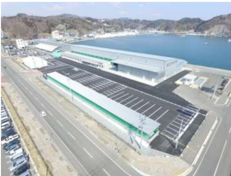
前の写真の反対側から撮影。手前側が増設棟、奥側が既設棟。
