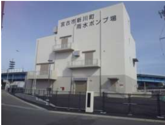
新川町雨水ポンプ場
