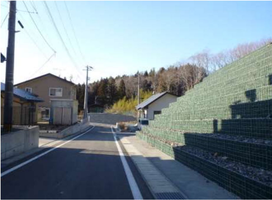
【道路整備(完成)】
