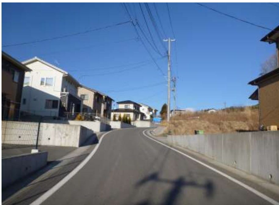
【道路整備(完成)】
