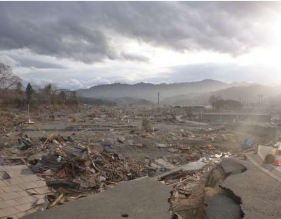
【被災状況(赤前地区)】
