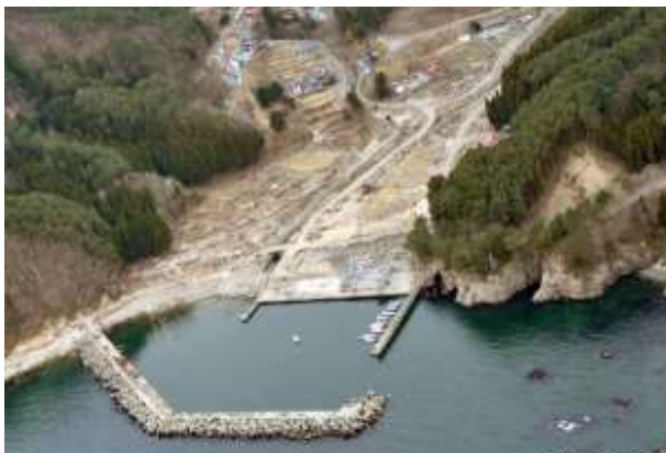
【被災後】 集落全景
