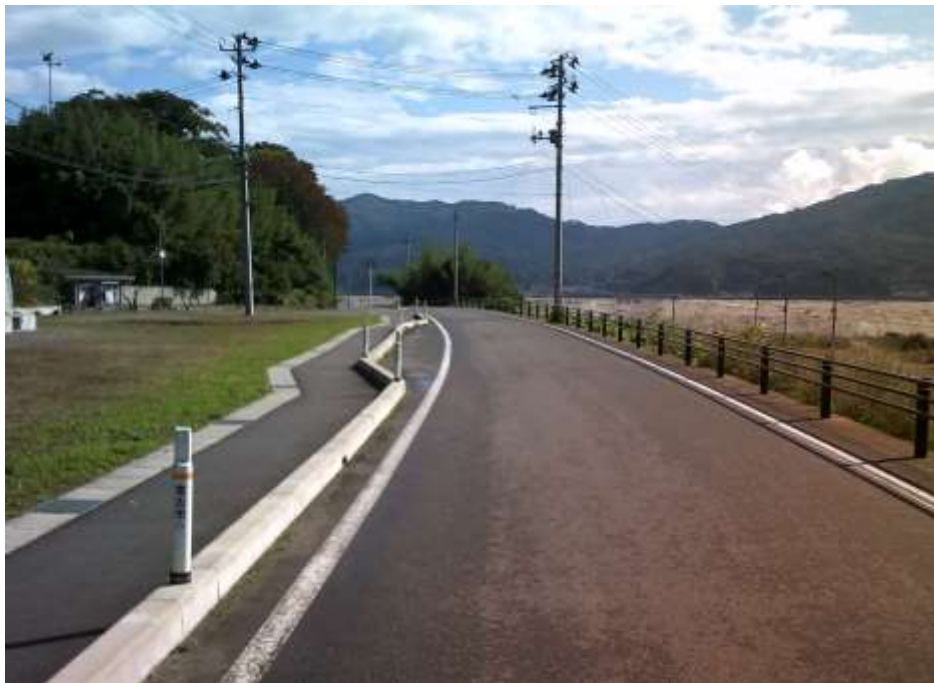
【道路整備(完成)】
