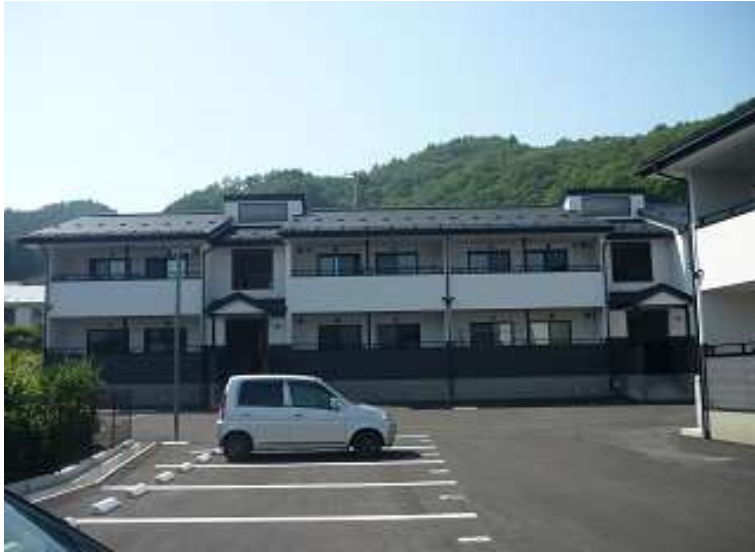
高浜災害住宅(完成)
