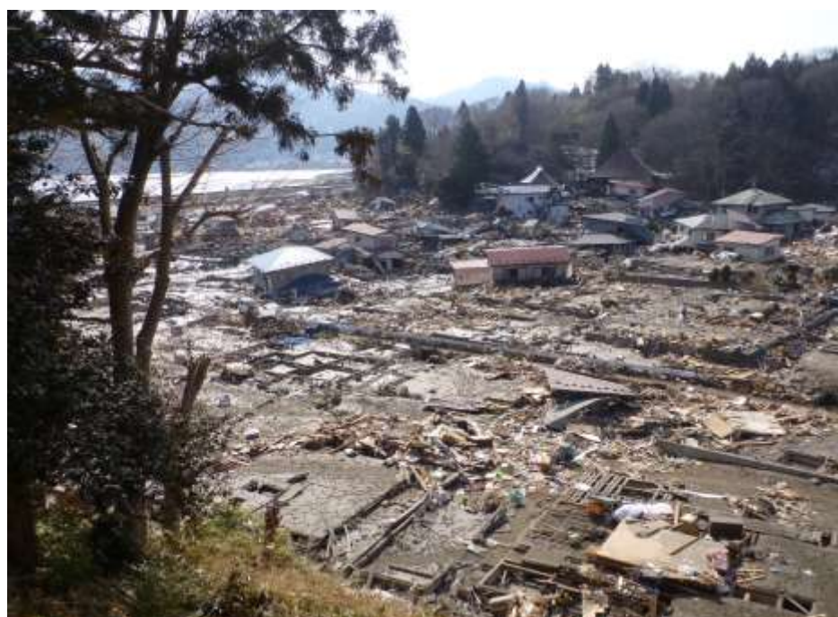
【被災状況(金浜地区)】
