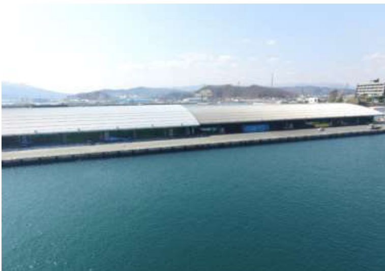
海側から撮影。建物の左半分が増設棟、右半分が既設棟。
