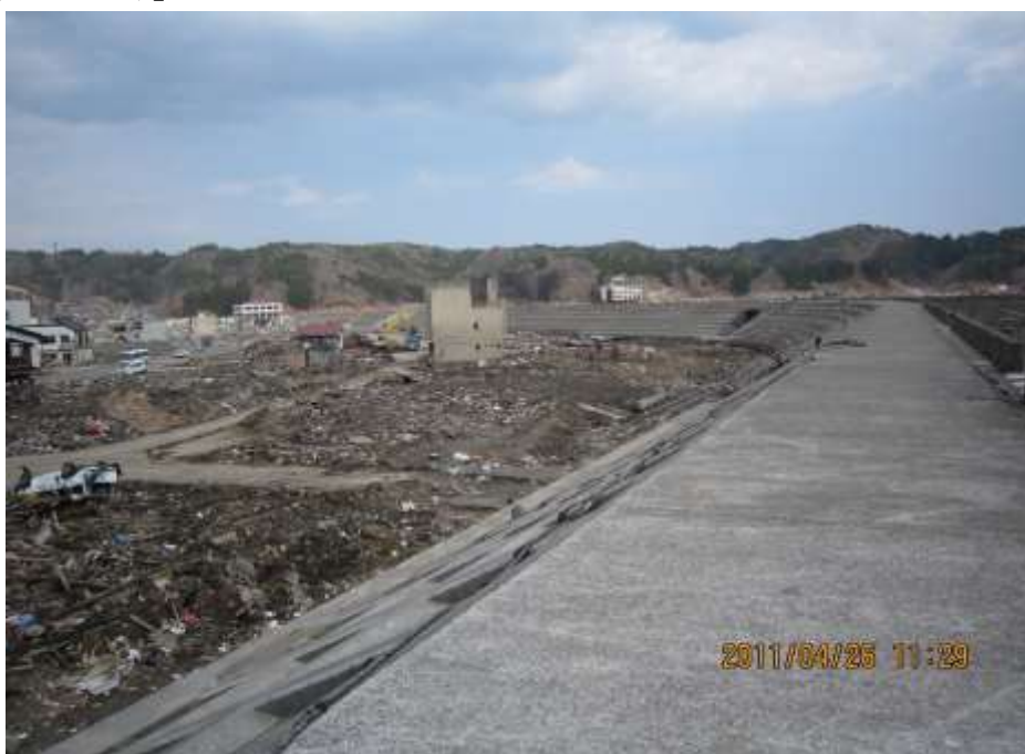
【被災状況(田老地区)】
