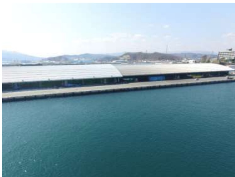
海側から撮影。建物の左半分が増設棟、右半分が既設棟。
