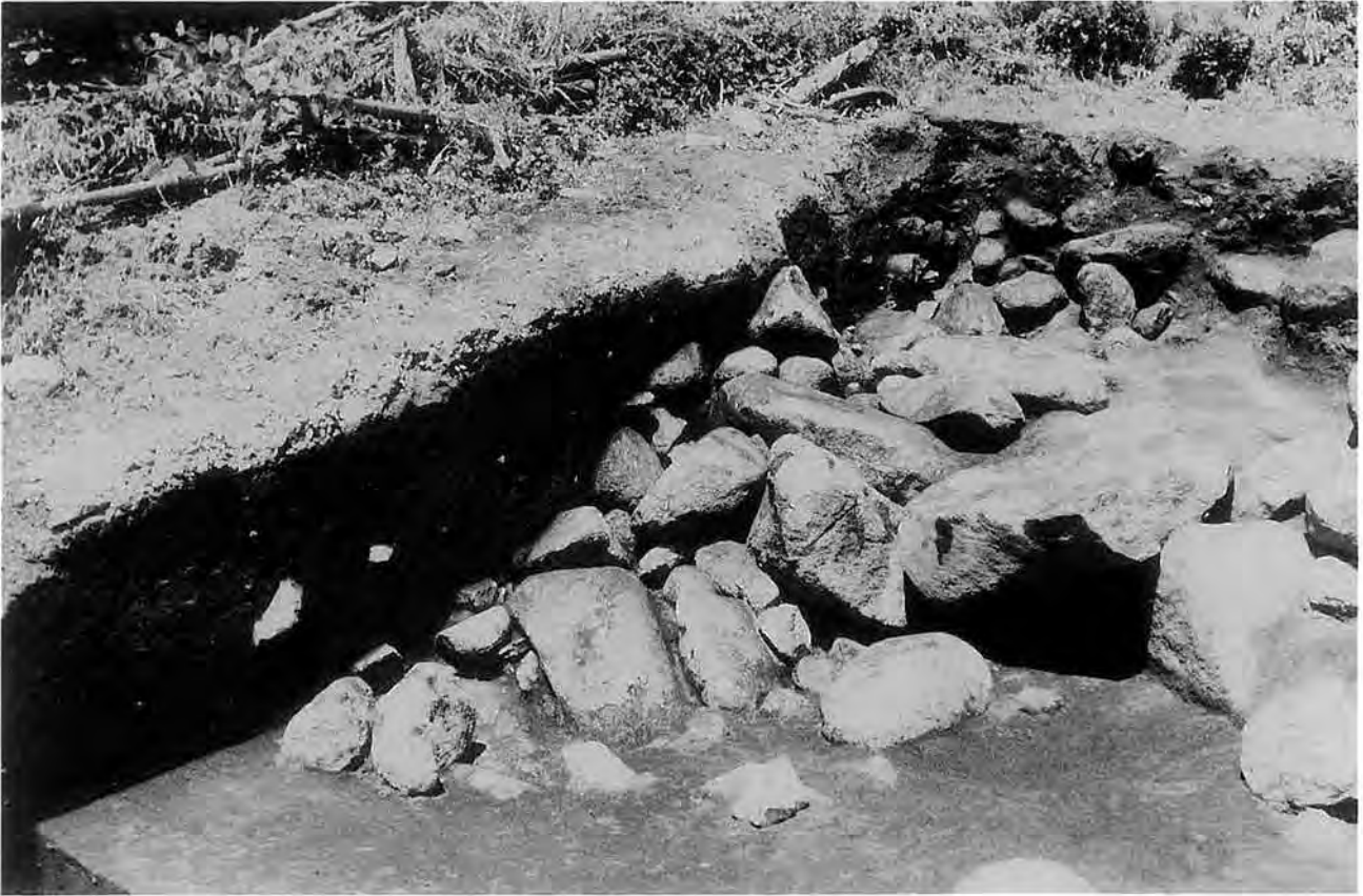
土砂（礫）流出状況（北西区）
