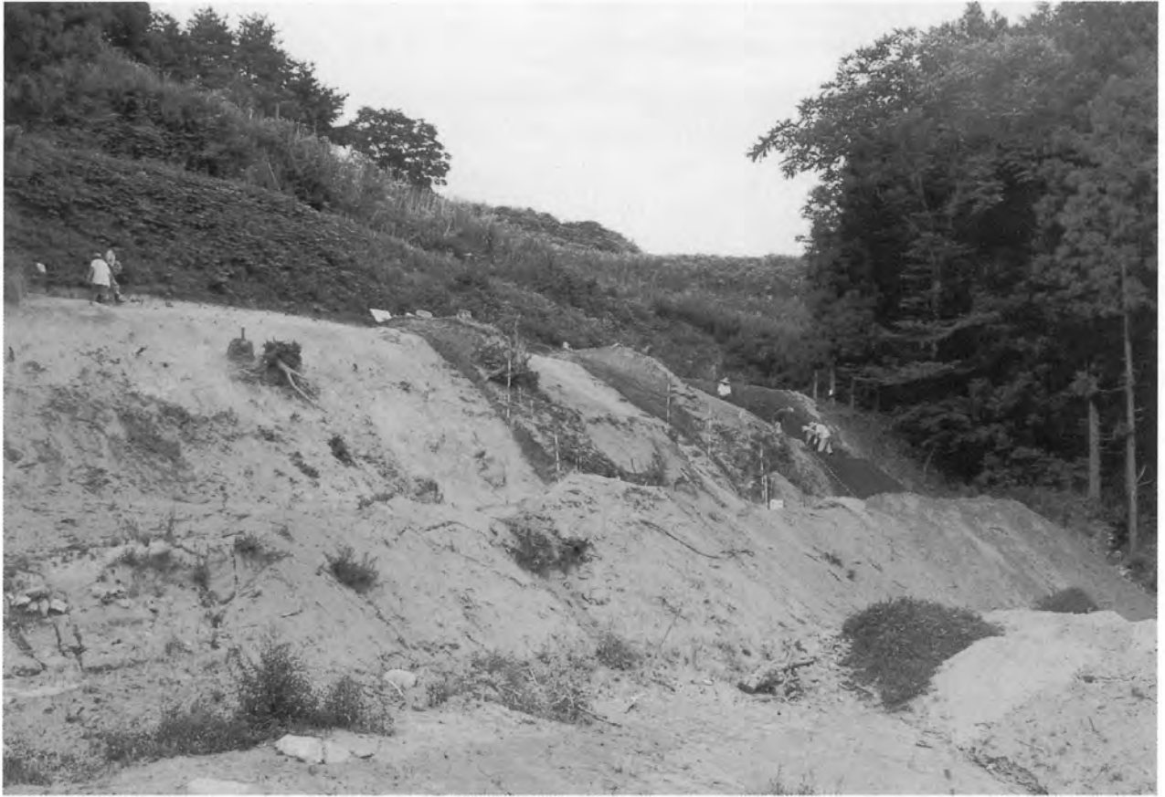
B区作業状況（西から）
