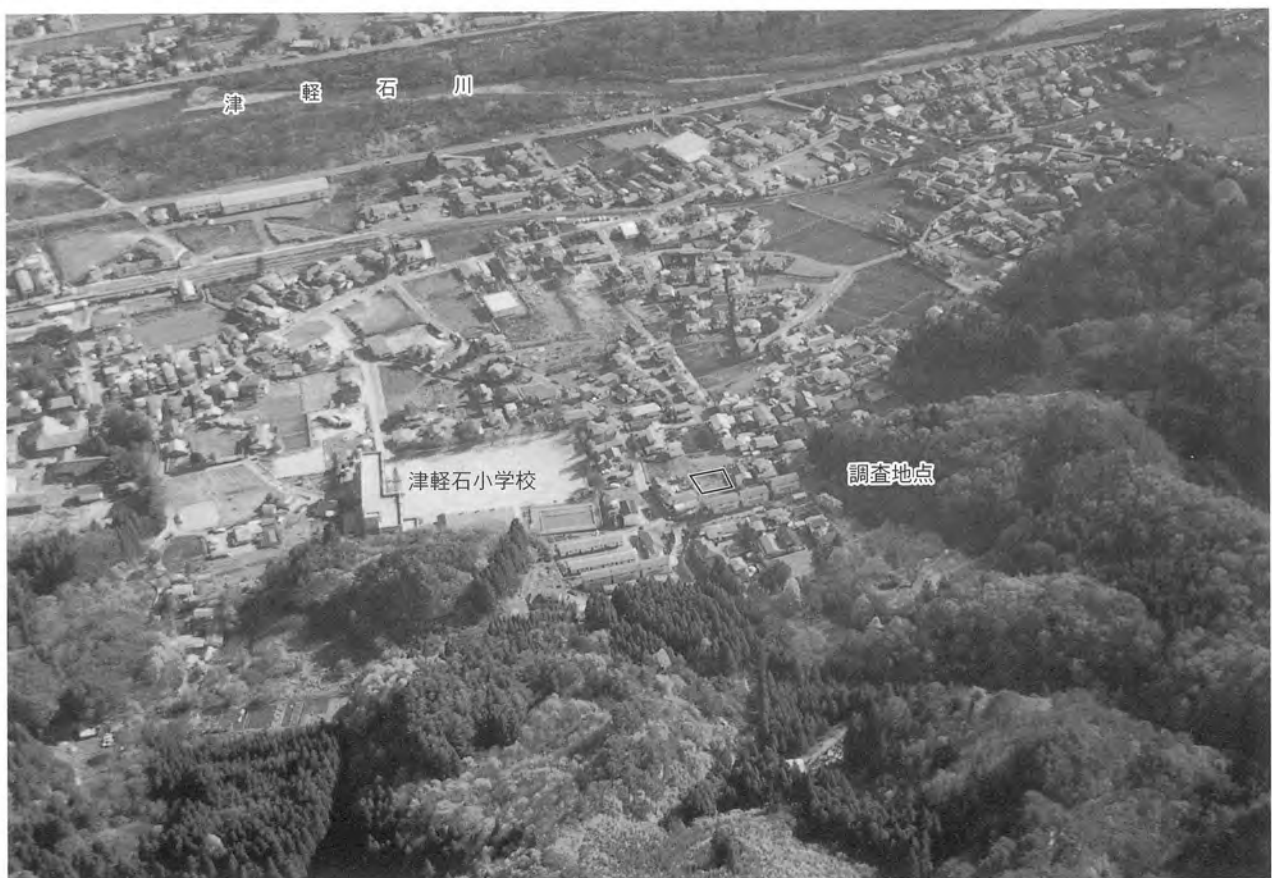
調査区遠景（北から）
