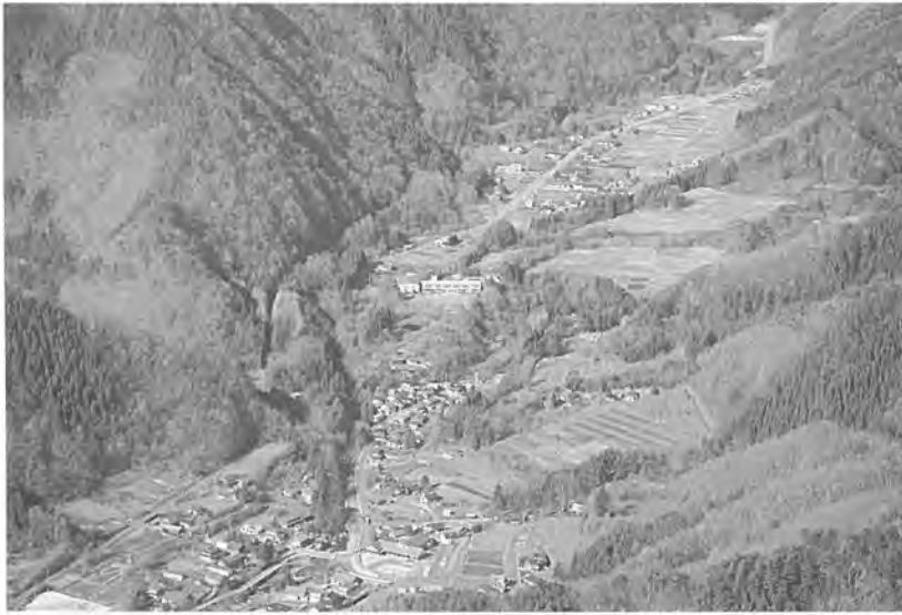
写真図版52 和井内地区現況（南から）
