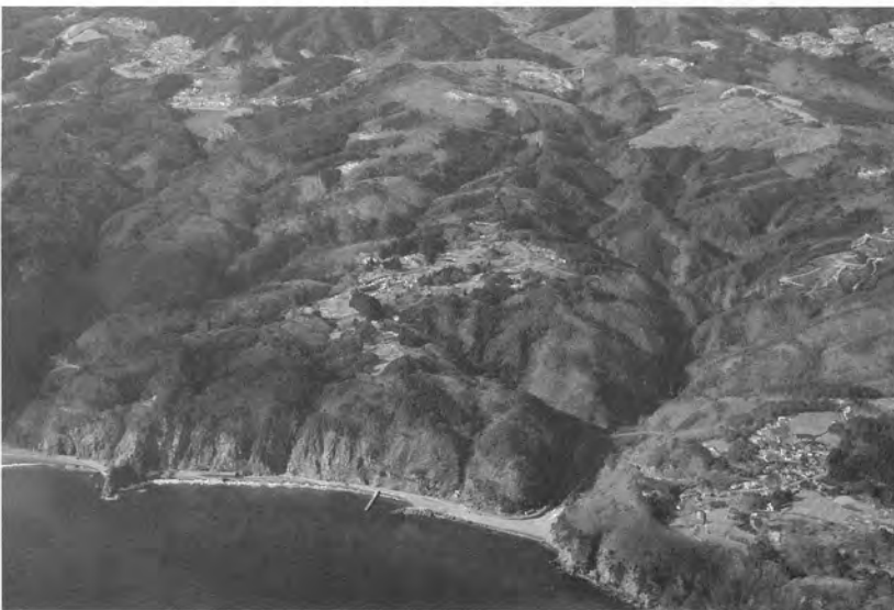
写真図版20 重津部 I 遺跡現況 （東から）
