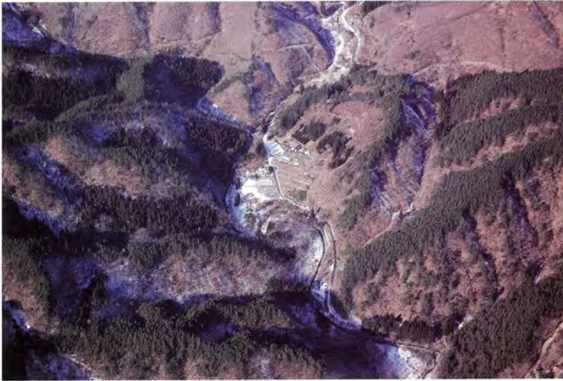
写真図版1 加倉遺跡 現況 (写真中央が遺跡・南から)
