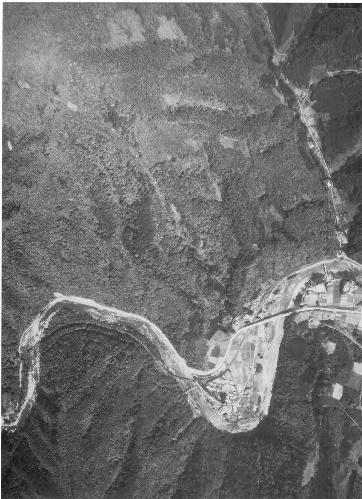
写真図版54 腹帯地区航空写真(1) (縮尺=1/8000 NO.C9-1622) 腹帯第3地割(水神)、第4地割付近。
