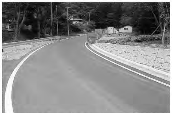
69. 市道蜂ヶ沢線工事完了状況 (東→)
