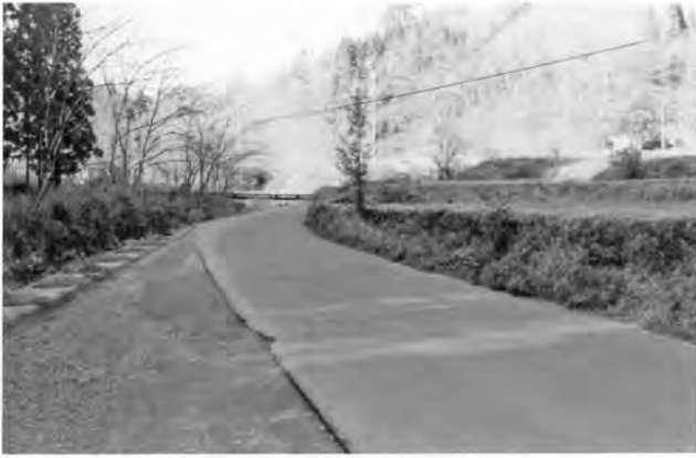
14. 平成16年度 調査前現況 (東→)
