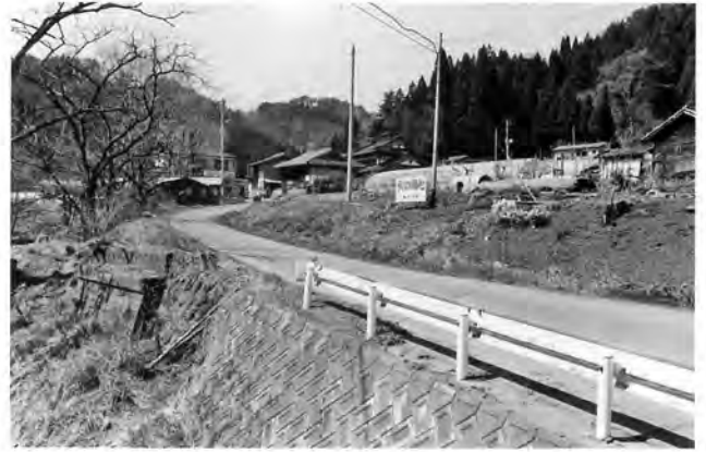
50. 平成22年度 調査前現況 (東→)
