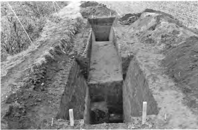
16. Fトレンチ 完掘状況 (東→)
