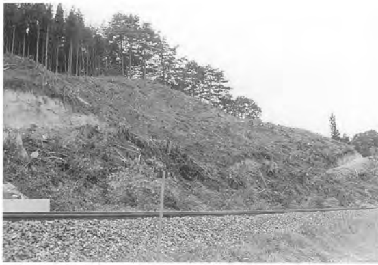
71. 試掘調査区 遠景（北→）
