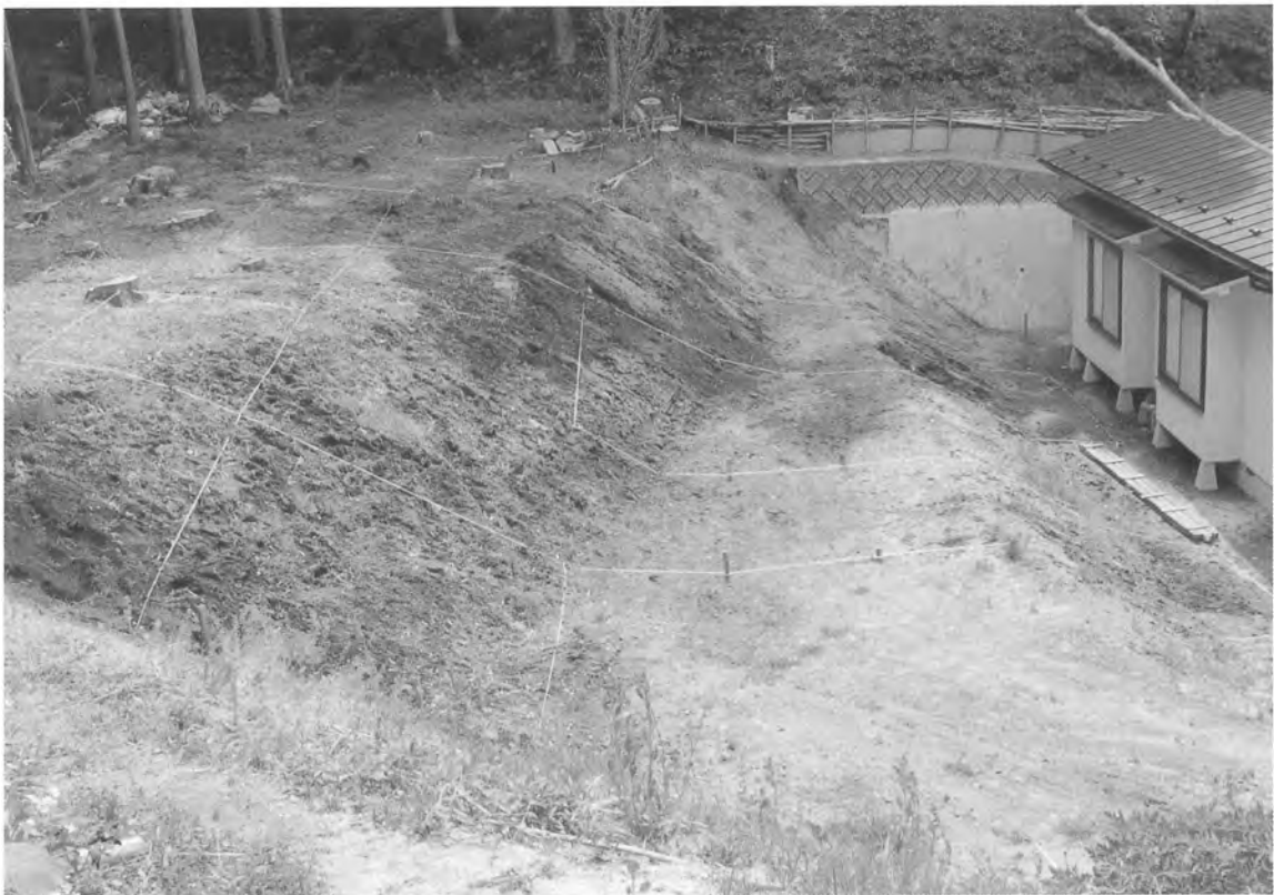
2. 試掘トレンチ設定時近景（西→）
