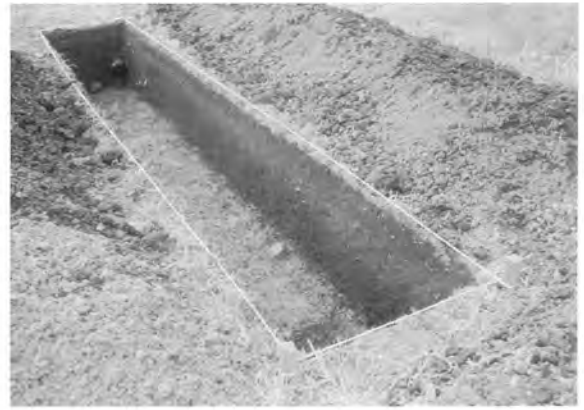
35. Lトレンチ 調査状況 (東から)
