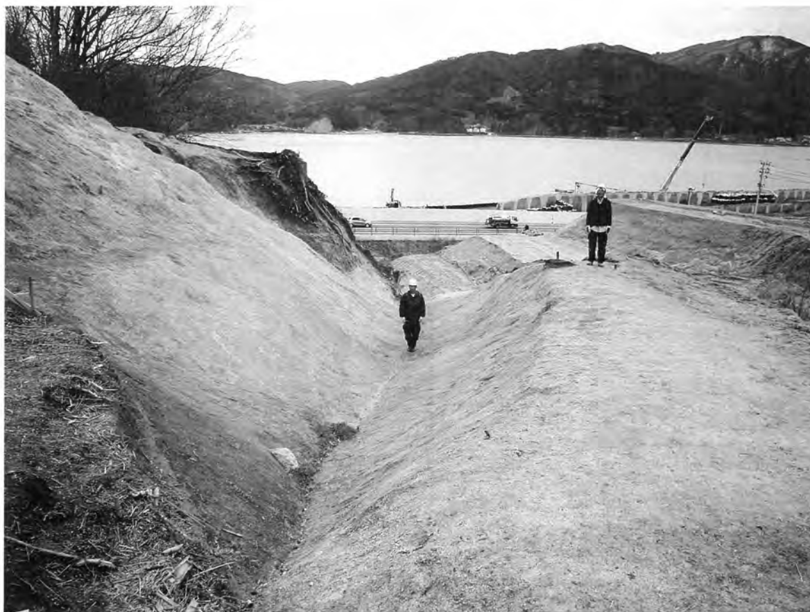
5 MD101 堀跡 完掘 (1) (西から)
