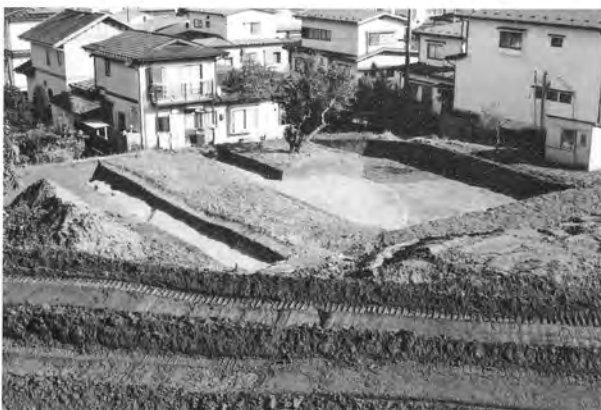
写真52 2次調査区調査完了状況
