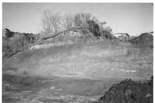
写真53 4次調査区調査完了状況
