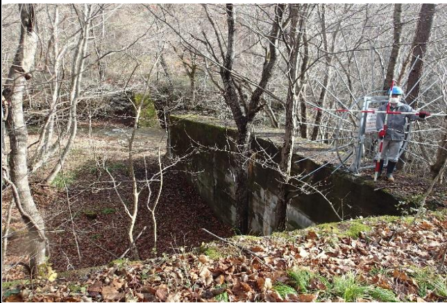
えん堤堆砂状況(満砂)
