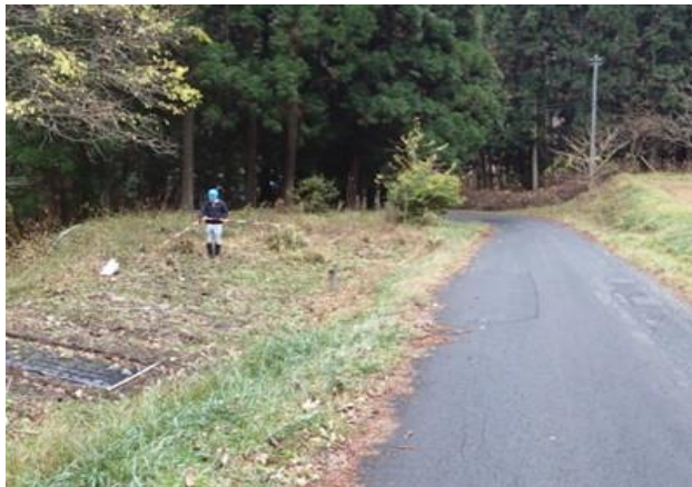
道路から作業ヤードへの摺り付けはよい
