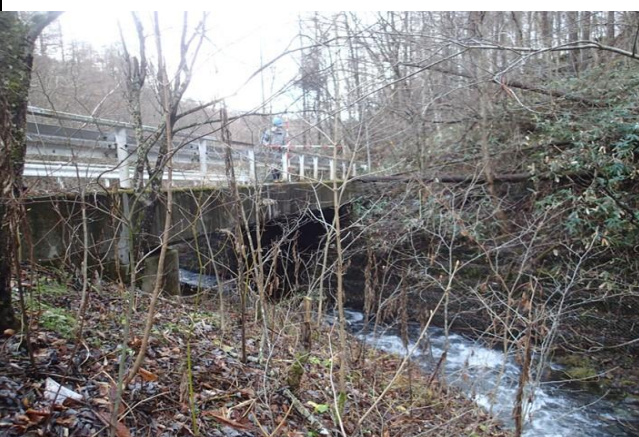
放水ルート上流側の橋梁通過部
