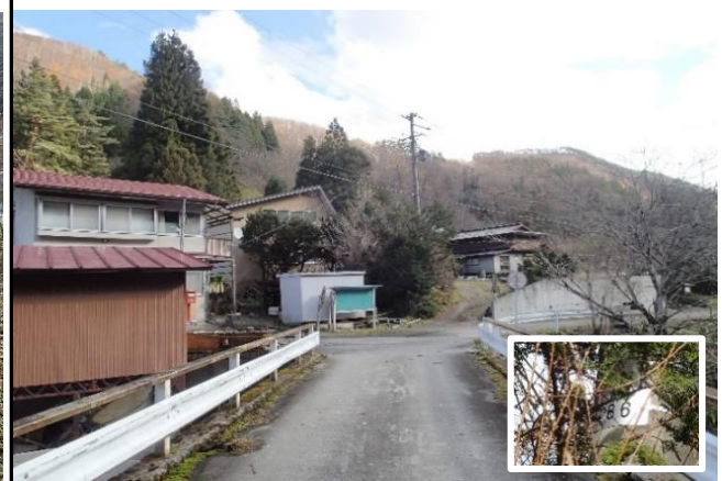
放水地点最寄りの高圧配電柱(夏屋線86)
