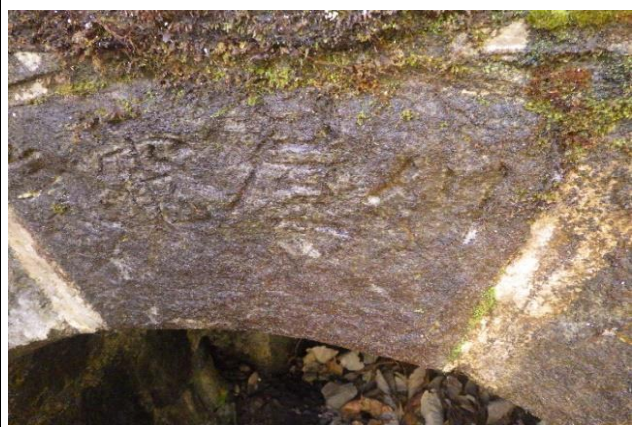
導水トンネルに「刈屋電気」の銘が刻まれている。
