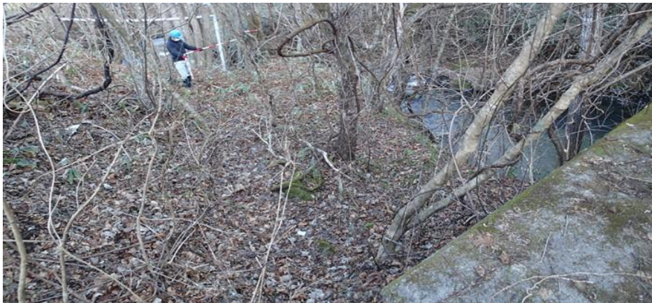
治山施設下流左岸側の沈砂池スペース
