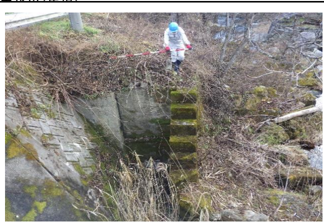
沈砂池跡、導水路入口
