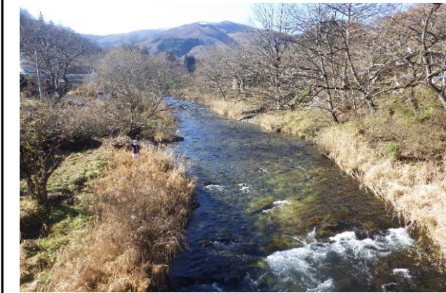
取水地点正面(取水堰跡と推定)
