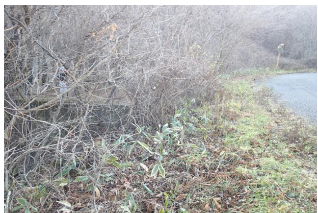
治山施設左岸側の林道への摺り付けはよい
