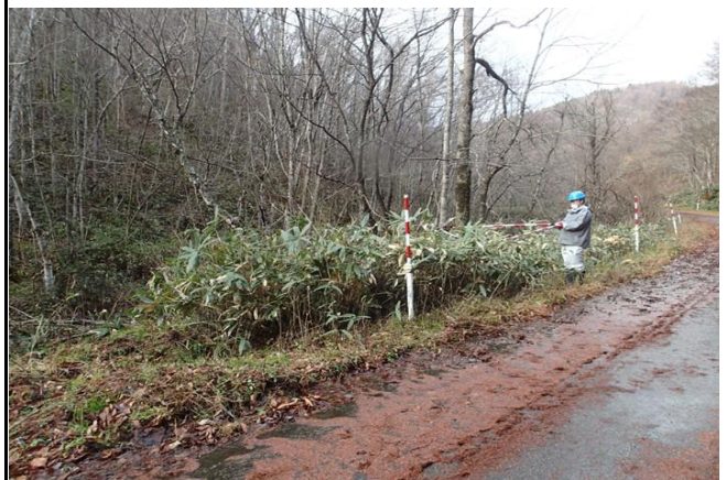
沈砂池スペース
