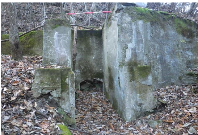
余水路・排砂路跡
