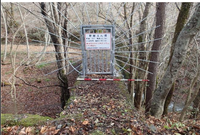
砂防えん堤標識、堤体天端厚1.5m
