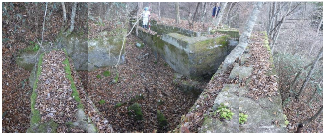
水槽跡。田代川の水槽跡に比べ大きく、使用水量が多かったと考えられる。
