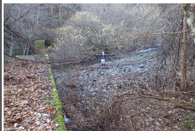
堰堤堆砂状況(満砂)
