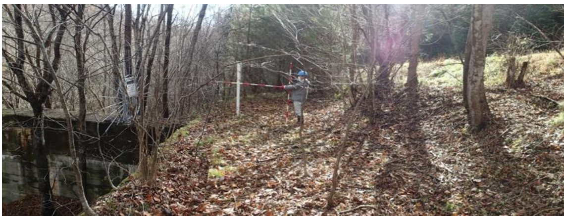
砂防えん堤右岸側の林道への摺り付けはよい
