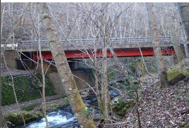
放水ルート上流域の橋梁通過部(栗木平橋)
