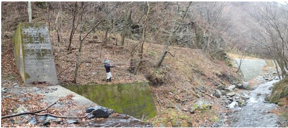
取水地点左岸側の沈砂池スペース
