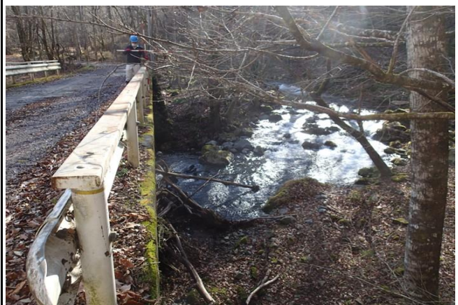
放水ルート橋梁通過部(吉部沢橋)
