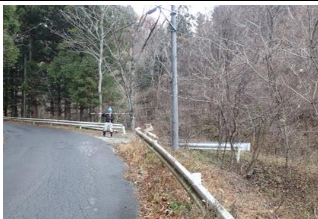
取水地点右岸側の林道への摺り付けはよい
