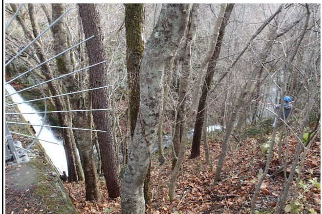
沈砂池スペース(右岸側)
