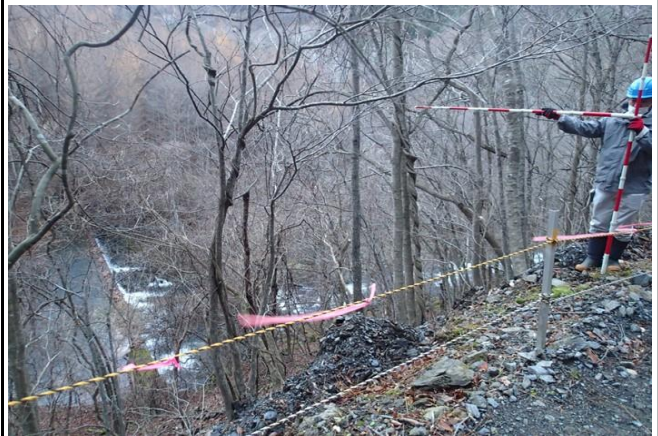
沈砂池スペース遠景(堤体下流右岸側)
