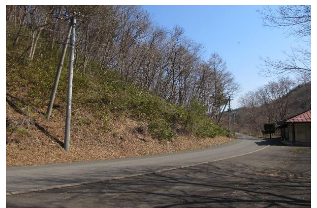
導水は主要地方道で分断されている。
