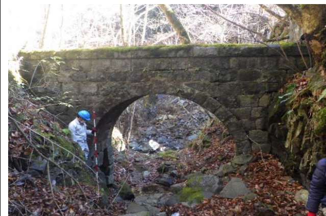
水路橋跡を上流から望む。
