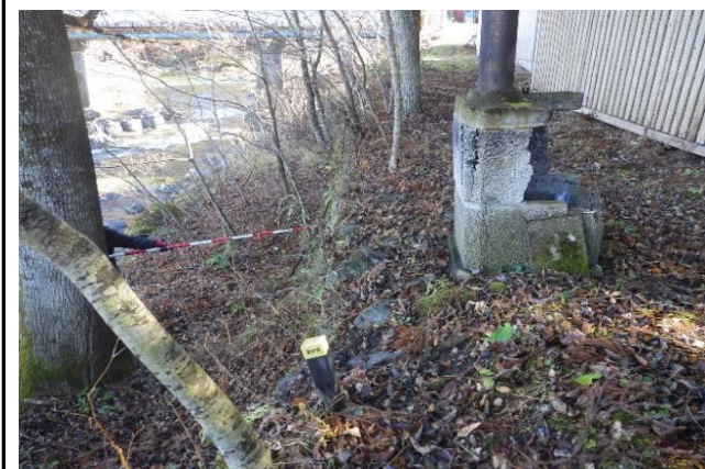
発電所地点(近景)
