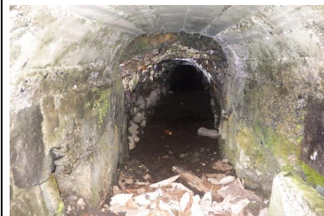
導水トンネル内部
