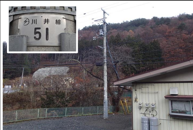
放水地点最寄りの高圧配電柱(川井線51)
