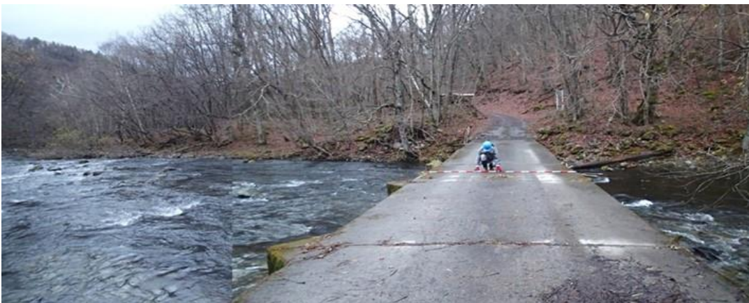
取水地点下流側、林道通過部の河道現況
