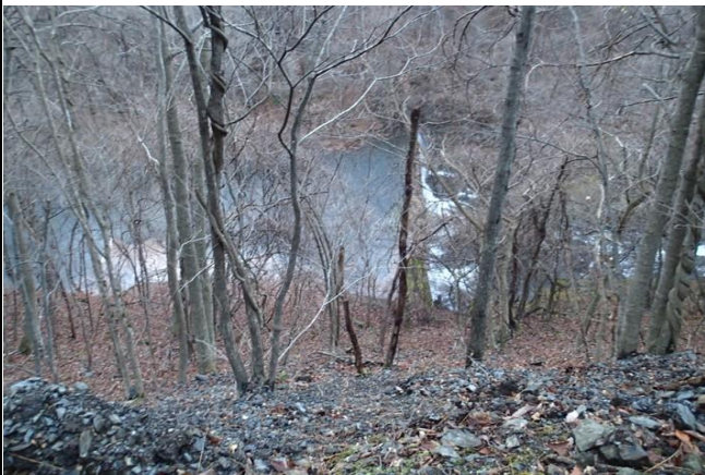
堰堤堆砂状況(満砂)
