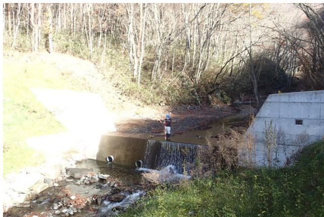
取水地点下流100mに設置された治山施設
