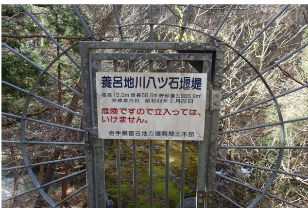
砂防堰堤銘板
