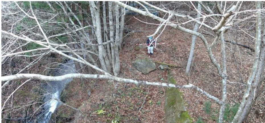
砂防堰堤下流右岸側の沈砂池スペース
