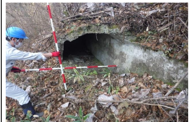
導水路跡(蓋渠形式)
