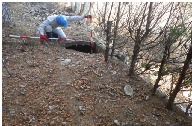
導水路跡(蓋渠形式)
