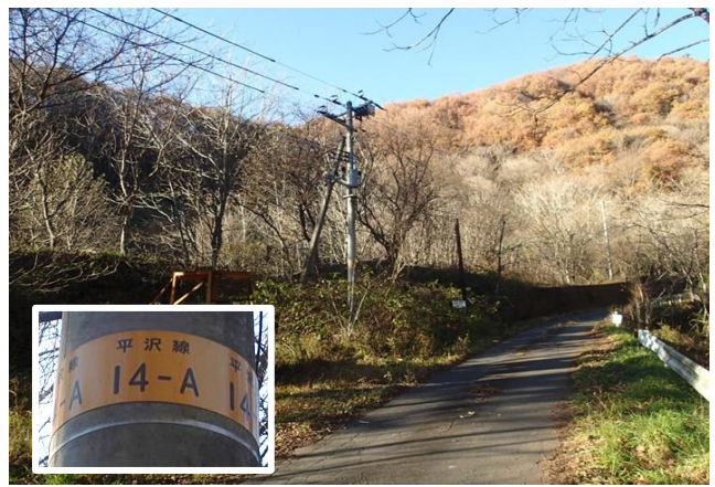
放水地点最寄りの高圧配電柱(平沢線14-A)
