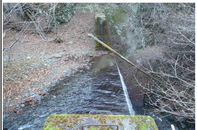
堰堤水通し(天端幅2.4m)
