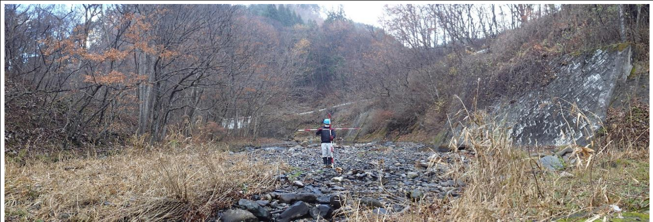
取水地点正面(取水堰新設)
