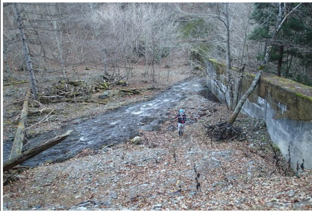
堰堤堆砂状況(満砂)
