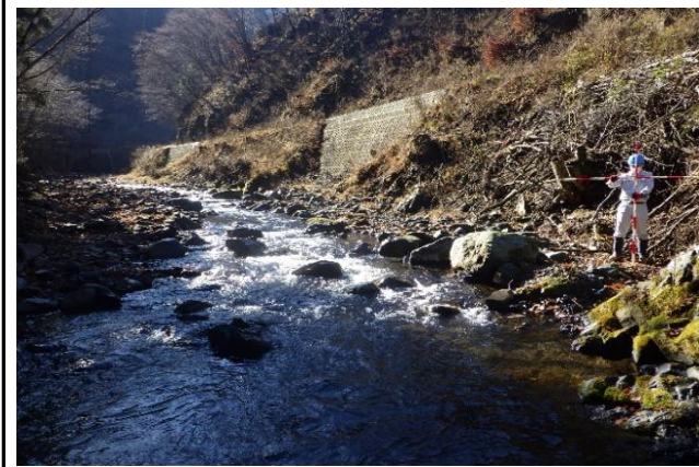
取水地点正面(取水堰跡)
