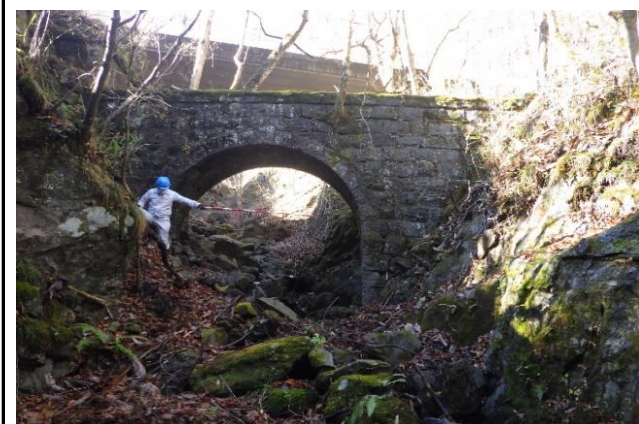
水路橋跡(自然石積)を下流から望む。
