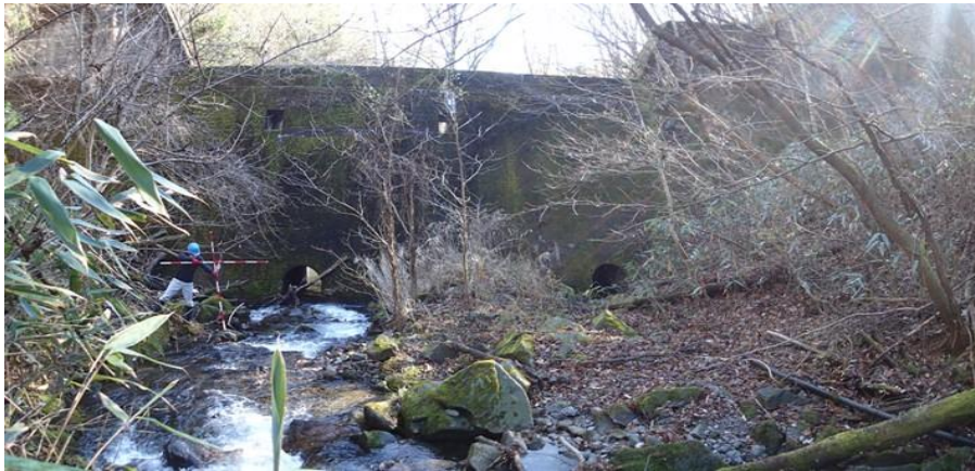
砂防堰堤堆砂状況(未満砂)
