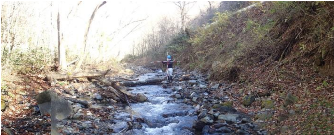
取水地点正面(河床と道路の比高差は7m程度)
