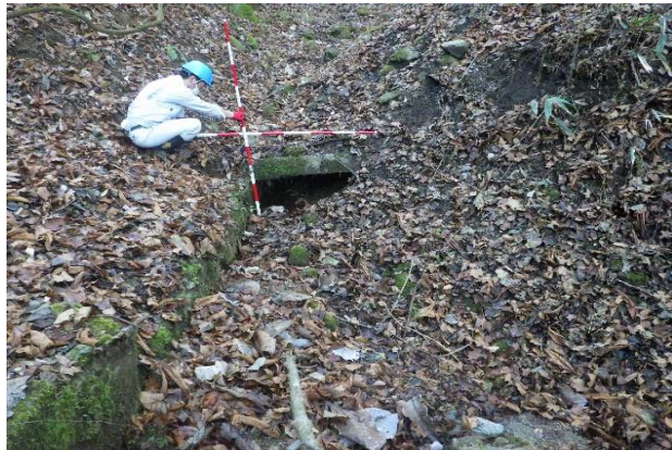
導水路跡。導水路トンネルのルートは不明である。
