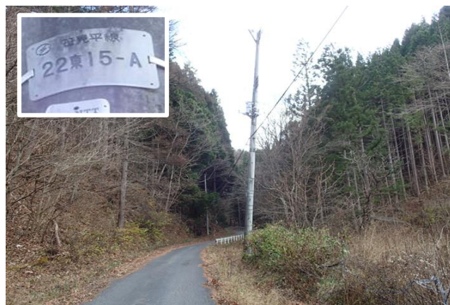
放水地点最寄りの高圧配電柱(笹見平線22東15-A)
