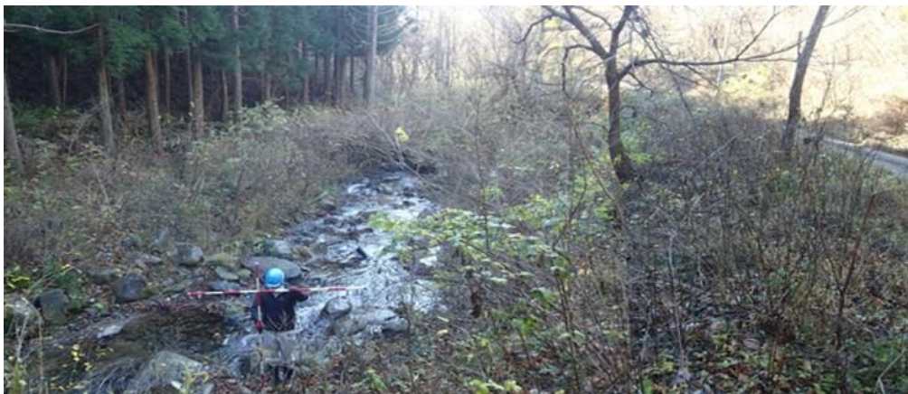
取水地点下流右岸側の沈砂池スペース
