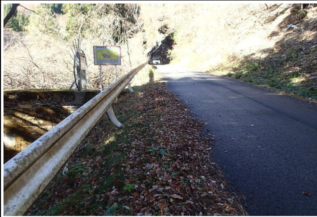
砂防堰堤左岸側の林道への取り付けはよい
