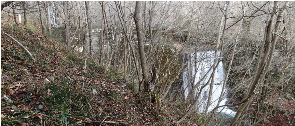
取水地点正面(夏屋えん堤, 宮古土木センター)
