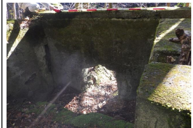
水圧管路入口
