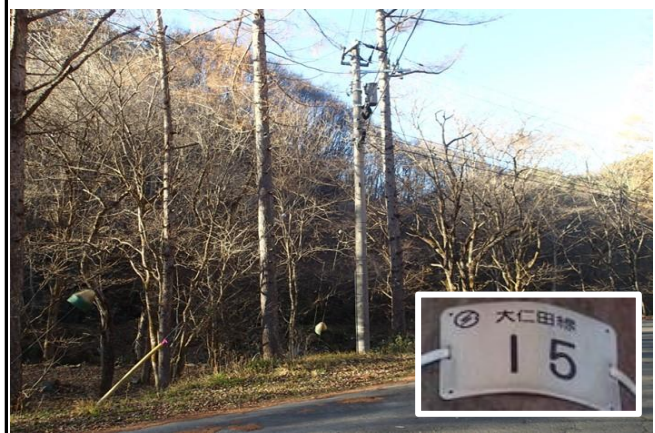
放水地点最寄りの高圧配電柱(大仁田線15)
