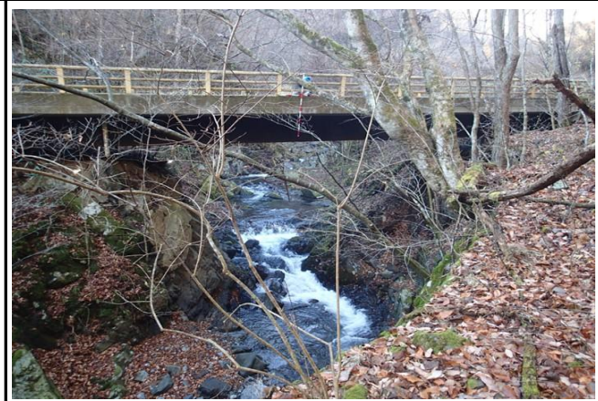
放水ルート橋梁通過部(害鷹森橋)
