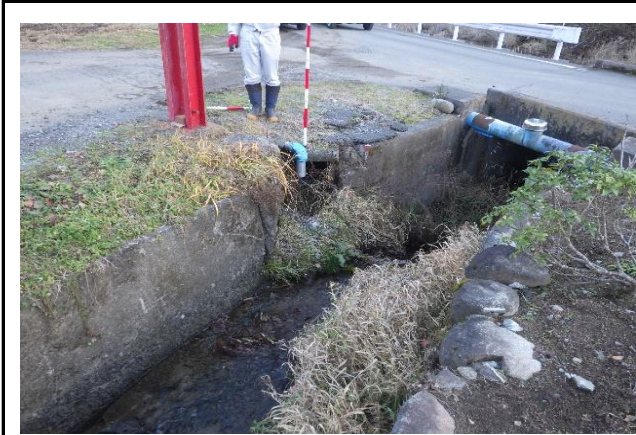
取水口跡、左支川からも取水していたとのこと。
