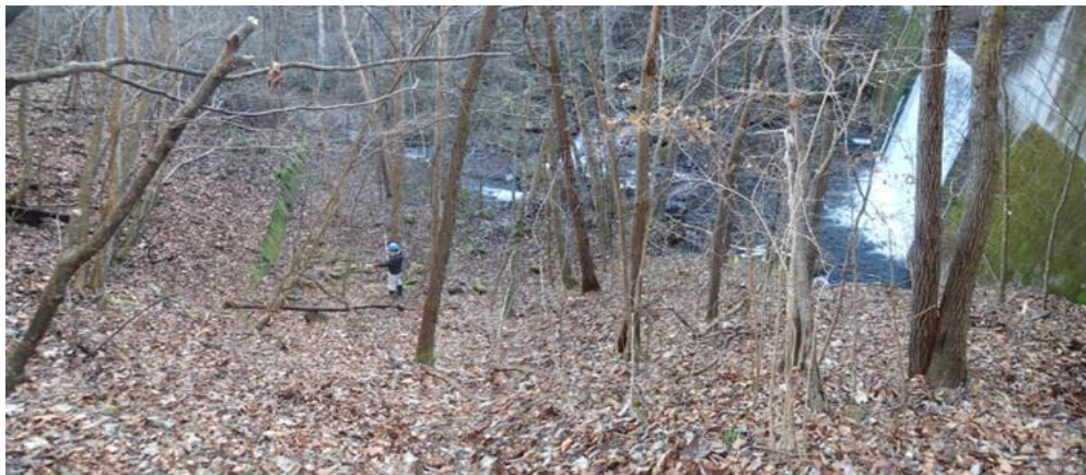
堰堤下流左岸側の沈砂スペース
