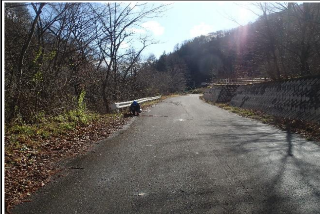
林道は順勾配のため放水ルート設置に適している
