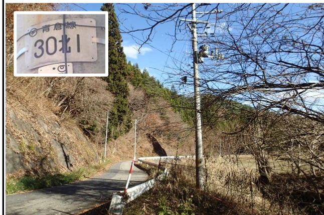
放水地点最寄りの高圧配電柱(青倉線30北1)
