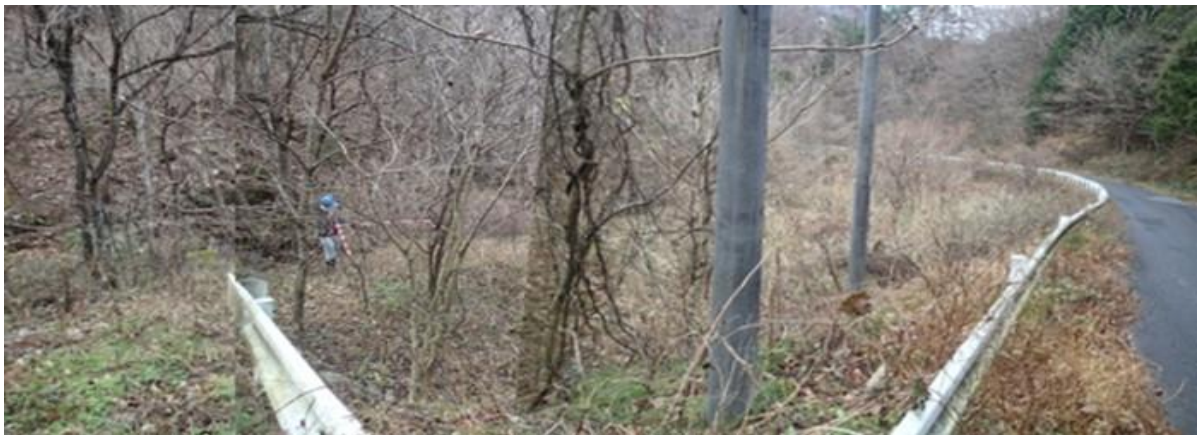
取水地点右岸側の沈砂池スペース
