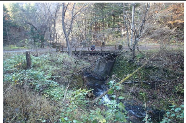
放水ルート上流側の橋梁通過部(平澤橋)
