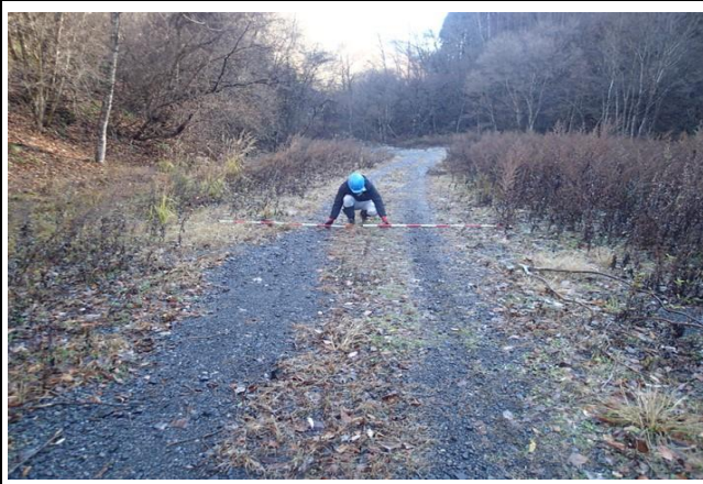
林道は順勾配のため放水ルート設置に適している
