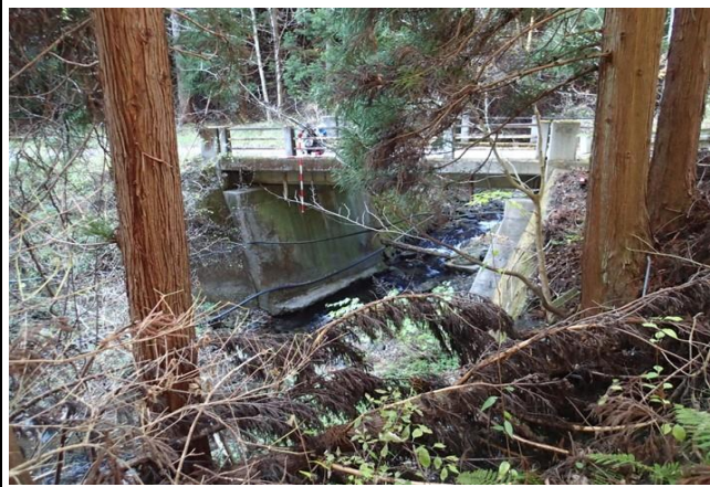
放水ルート下流側の橋梁通過部(第一平沢橋)
