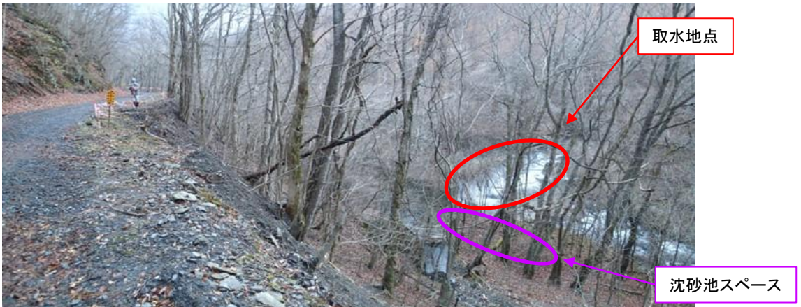
取水地点正面(取水地点と林道の比高差は25m程度)。堰堤下流右岸側に沈砂池スペースが確保できる
