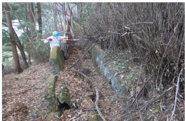
導水路跡(蓋渠形式)
