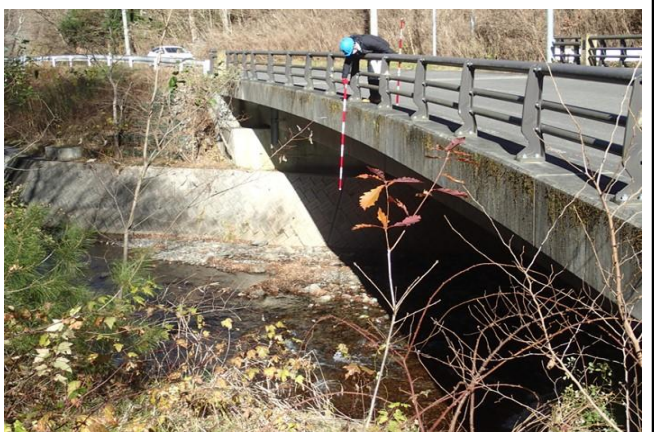
放水ルート橋梁通過部(馬草橋)
