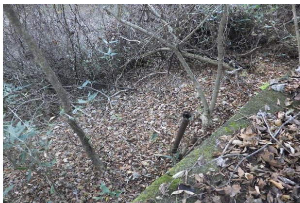
水圧管路跡、給気管が見える。
