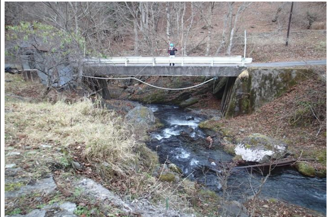
放水ルート橋梁通過部
