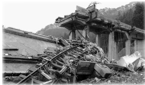
被災した旧島越駅の様子
