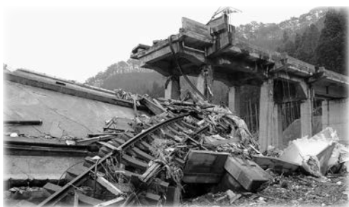
被災した旧島越駅の様子
