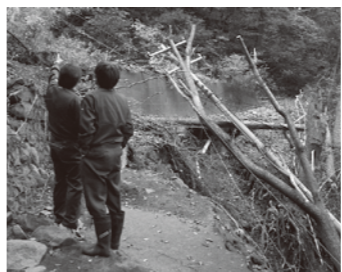
台風19号の被害を調査する委員会の様子
