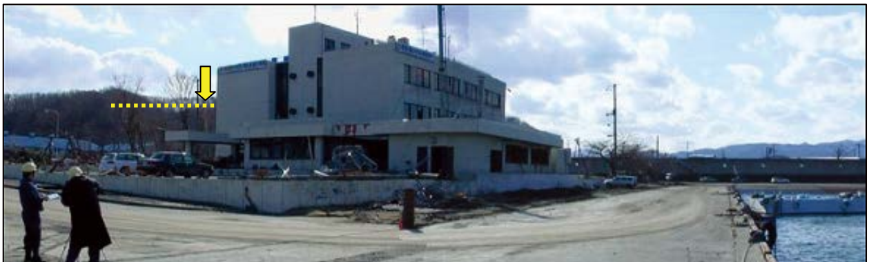
写真 103 津波の痕跡 (第 3.2.83 図の 103) 樹木で漂着物を確認
