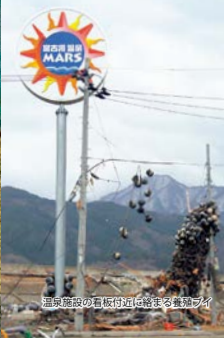
高浜に位置する高浜小学校の校庭にも津波が襲来した。目の前の力でフェンスが崩壊している
