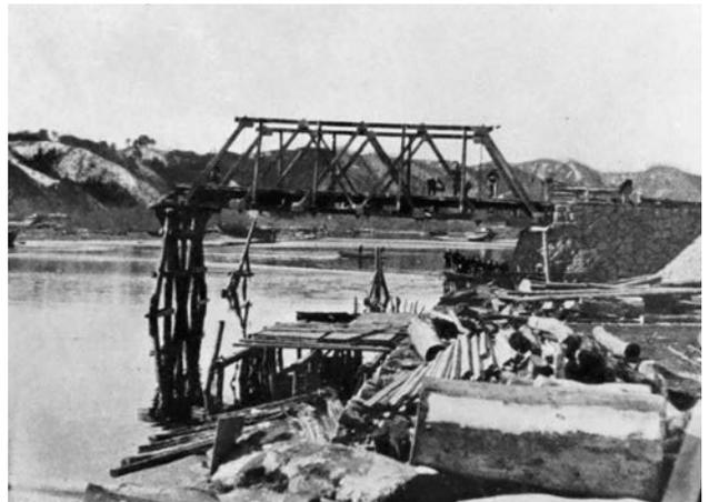
【写真 39】 宮古町（津浪に押し上げられた船のために破損した宮古橋）【中央気象台】
