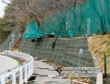
高浜に位置する高浜小学校の校庭にも津波が襲来した。目の前の力でフェンスが崩壊し倒れている
