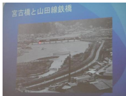
宮古橋と山田線鉄橋
