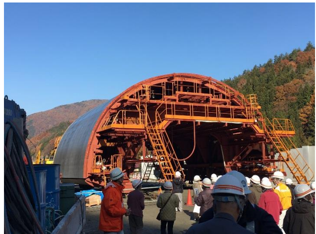
トンネル外に出ているセントル
