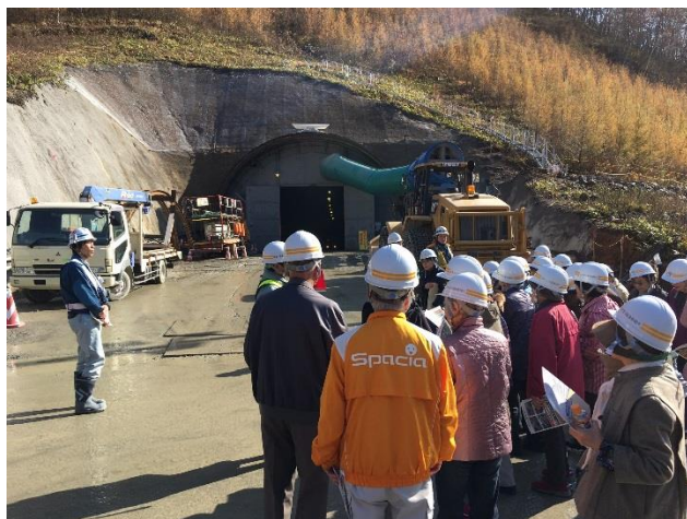
岩井地区トンネル
