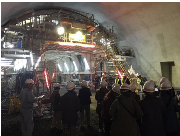
セントルによる作業状況
