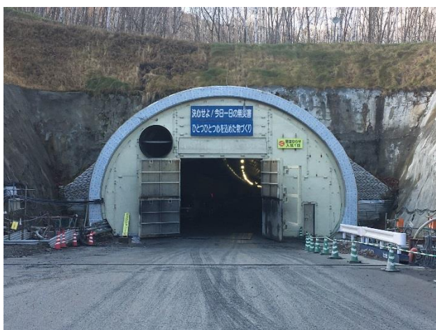
新区界トンネル
