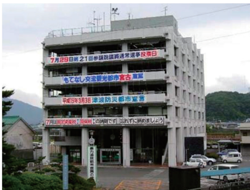
左：本庁舎(本館)（昭和47年竣工）
