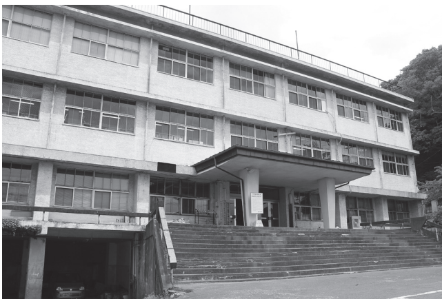
完成から50年以上が経過する市役所分庁舎
