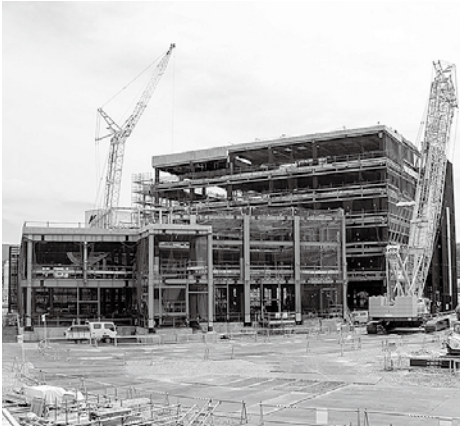
来年7月完成を目指して建設が進む中心市街地拠点施設
