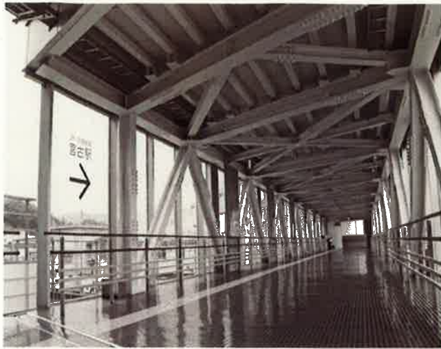
クロスデッキ内部。イーストピアみやこ側から駅側を向いて撮影
