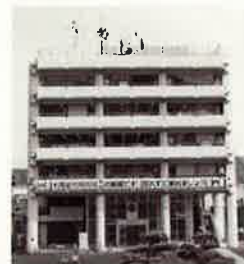
▷現・市役所本庁舎 および都市整備部第二事務所(新川町)
