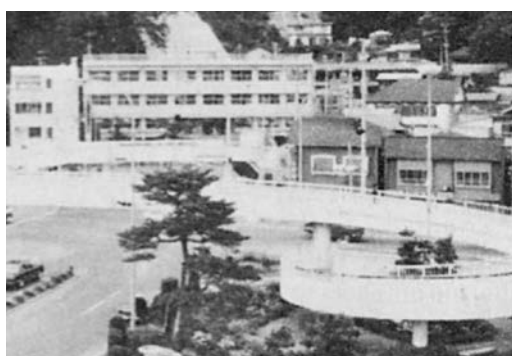
県から払い下げを受けた分庁舎（昭和59年5月撮影）
