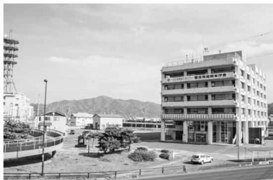
旧市役所本庁舎＝写真＝と分庁舎は今年度解体予定。
