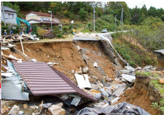
台風19号による被害（重茂地区・令和元年10月）
