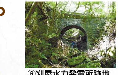
⑥刈屋水力発電所跡地
