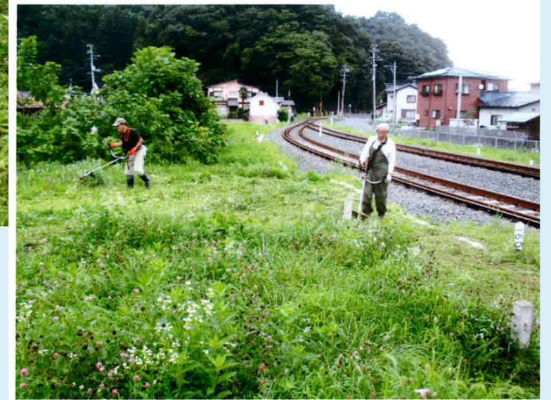
津軽石駅付近の草刈り作業
