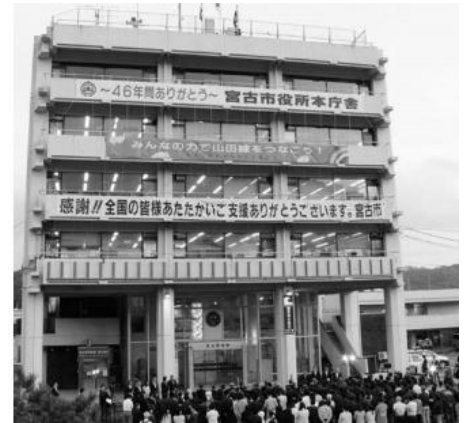
〔平成 30 年 9 月に閉庁した旧庁舎〕
