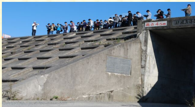
防潮堤での説明
