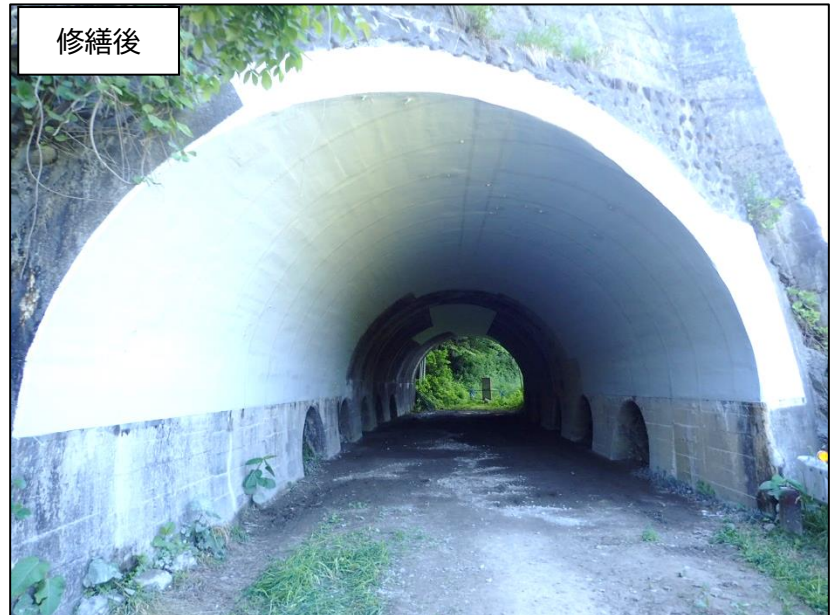
【写真】花原市トンネル（平成 29 年施工）
