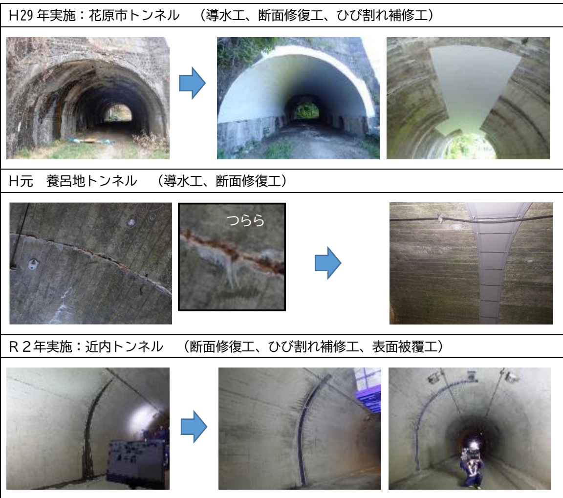
写真 6－1 修繕実施トンネルの状況
