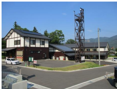
津波復興拠点施設（津軽石地区）
