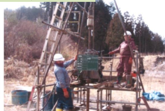
ボーリングマシン
