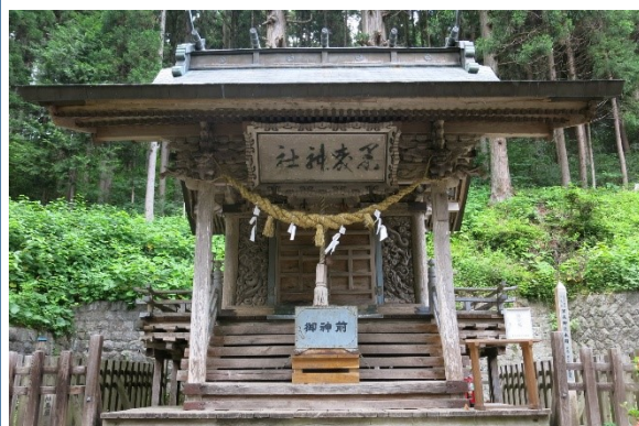
本殿正面（修復前）
