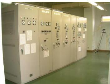
送水ポンプ操作盤…集水井から滅菌処理した水を配水池（高台）に送ります
